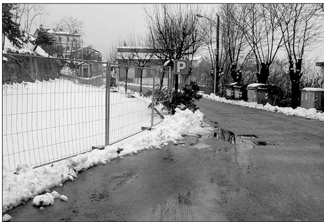
La piazza interessata dagli interventi di consolidamento.
