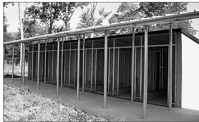
La nuova struttura con i box per animali.
