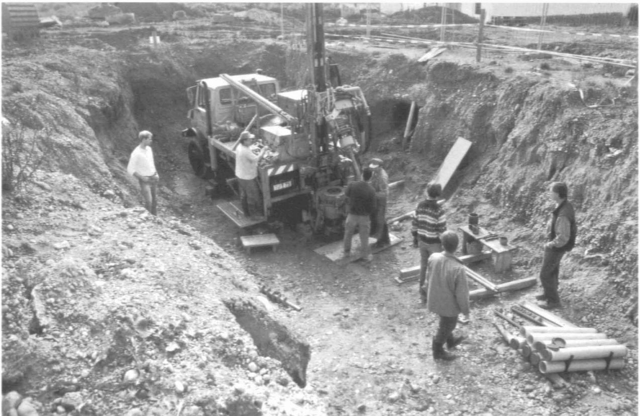
3 In einer Riedlinger Viereckschanze sollte der Schichtaufbau einer Schachtverfüllung und die Schachttiefe erkundet werden. Dazu wählte man die Rammkernbohrung mit einem Großbohrgerät. Rechts im Bild Röhren zum Einlegen der Kernstrecke.
