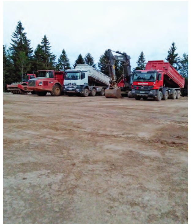
Großbaustelle für die Errichtung eines Windrades. Die mächtigen Türme brauchen entsprechende Fundamente und schweres Gerät zur Bearbeitung
