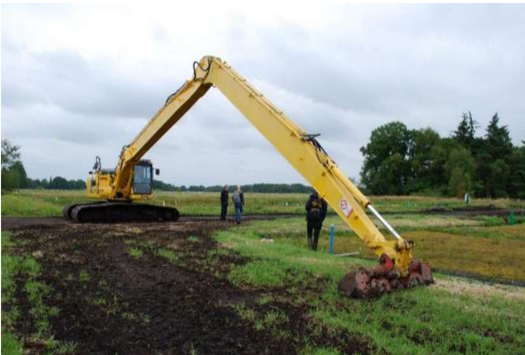
Abbildung 31: Kettenbagger für die Bewirtschaftung der Torfmoosanbauflächen Quelle: ARSU (2021)
