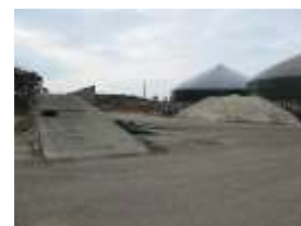
Abb. LVII: Biogasanlage bei Steinfeld
