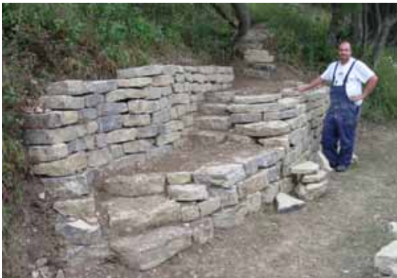
Abb. 12: Michael TILLY bei der Anlage einer Trockenmauer als Sonderstruktur für Reptilien. Hier im FFH-Gebiet „Kalkmagerrasen bei Dalhausen“ (Foto: D. KRÄMER).
