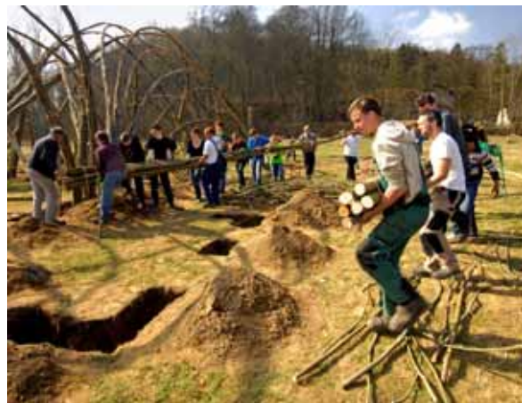
Abb. 21: Bau des Weidenpalais im Schlosspark von Rheder (Foto: F. GRAWE)
