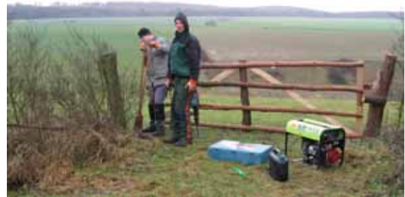
Abb. 13: Instandsetzung eines Weidetors am Hamberg (Foto: D. KRÄMER)
