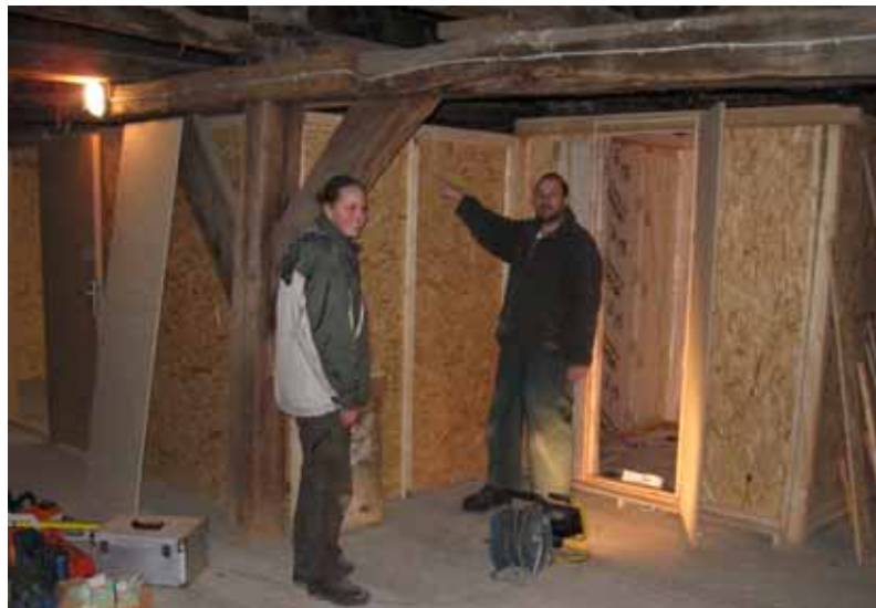
Abb. 16: Ausbau des Dachbodens im Steinernen Haus (Foto: Landschaftsstation)
