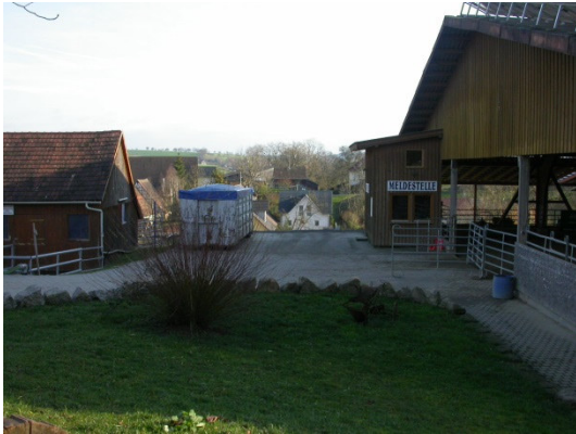
Bild 25: Östlicher Geltungsbereich und hier ebenfalls die östlichen Gebäudeteile mit der bestehenden Reit- und Lagerhalle sowie links im Bild ein Nebengebäude mit vorgelagertem kleinem Sand-Reitplatz
