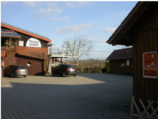
Bild 21: Gepflasterte Hofsituation, Zufahrtbereich zu den Bestandsgebäuden auf der Ostseite des Geltungsbereiches
