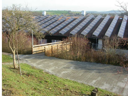
Bild 20: Blick nach Südosten auf das Bestandsgebäude, Gastronomie und Stallungen
