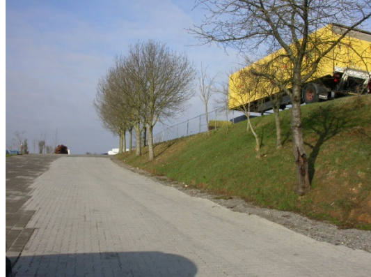
Bild 2: Gepflasterter Straßenabschnitt, Blick nach Norden. Links im Bild bestehende gepflasterte Stellplätze
