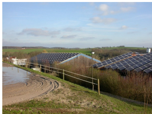
Bild 18: Blick nach Osten über die Bestandsgebäude -Gastronomie und Reit- und Lagerhalle bzw. Stallungen sowie bestehende Eingrünungen der weiteren Böschungsbereiche, rechts im Bild
