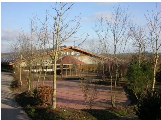
Bild 23: Blick nach Osten (Östlicher Geltungsbereich) auf eine bestehende Reitanlage am südlichen Ende des Geltungsbereiches
