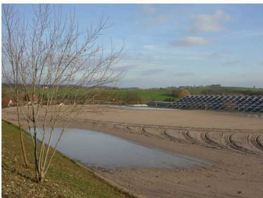
Bild 17: Östlicher Teil des Geltungsbereiches mit Blick nach Nordosten über den großen unbedachten Reitplatz und Anzeichen einer bereits starken Verdichtung des Reitplatzes - Wasserstände sind knöcheltief
