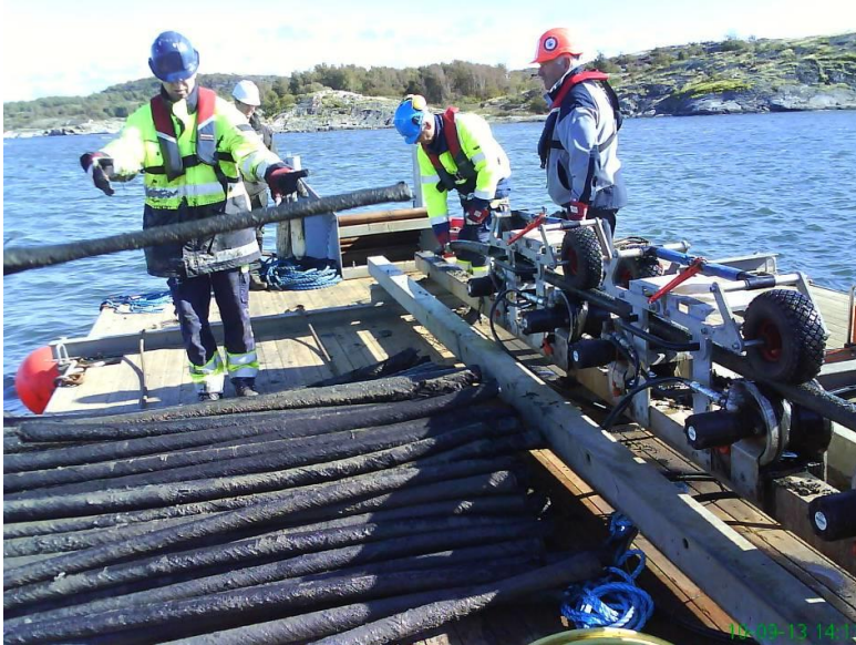
Kabeln klippas och stuvas på flotten.
