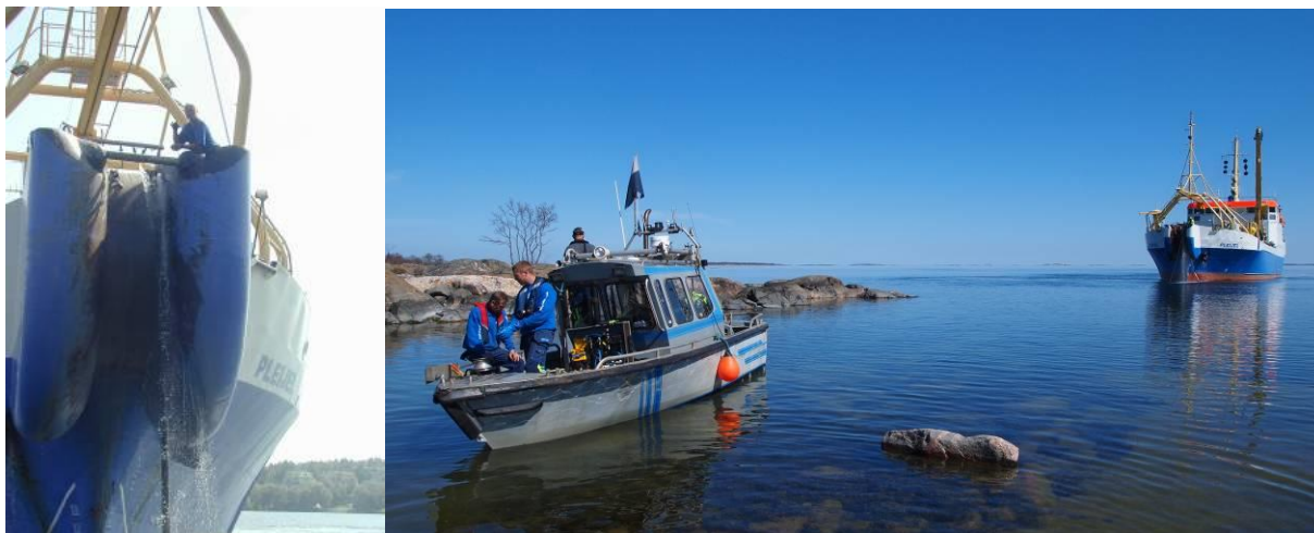
Ovan T.V. kabel över boghjul på C/S Pleijel -kabelns riktning övervakas ständigt av personal vid boghjulet. Ovan T.H Dykare i arbetsbåt följer bukten där kabeln går ut från land.
