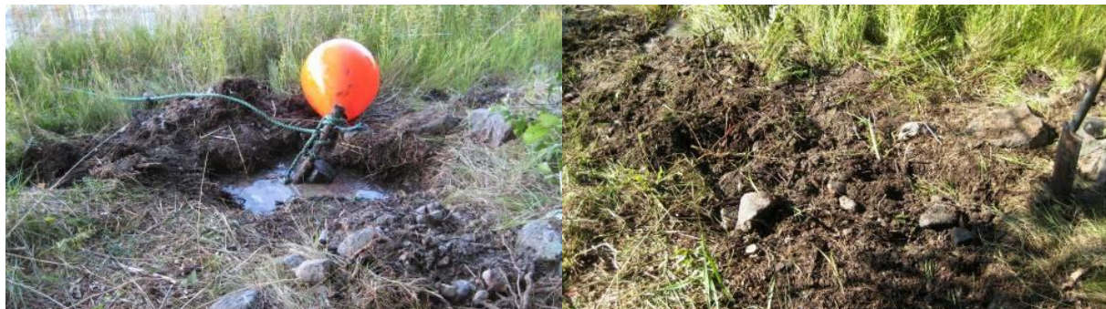
Kabel frilagd och kapad resp vid återställning
