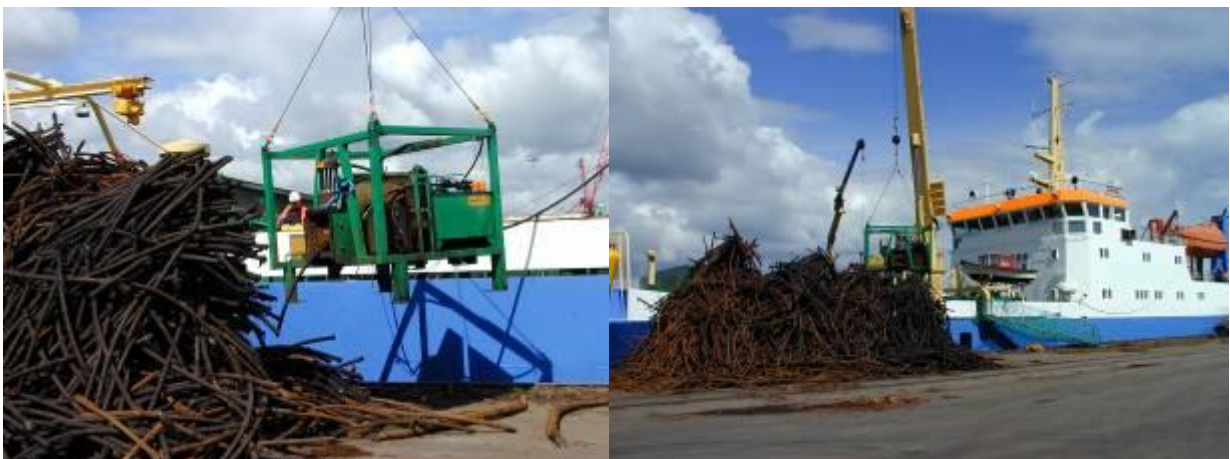
Ovan bilder på klippning av upptagen kabel
