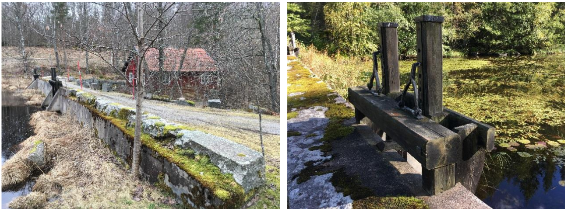
Figur 7. Bilden till vänster visar dammvallen med väg vid Strömsborgs kvarn. Bilden till höger visar en av dammluckorna i trä vid Strömsborgs kvarn. Foto: Annelie Claësson.
