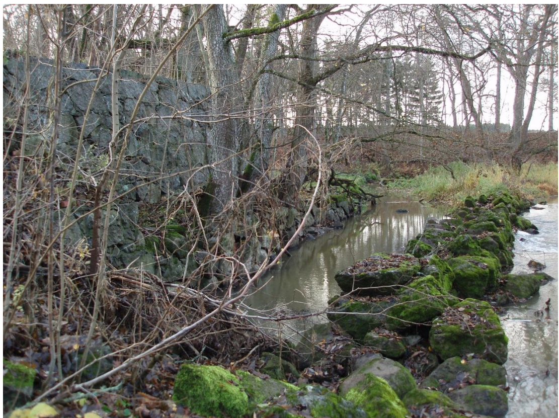
Figur 10. Den bevarandevärda kulturmiljön invid Tolefors utgörs av den murade sågkvarngrunden med intilliggande hjulgrav av kallmurade stenar. Foto: Malin Svarvar.
