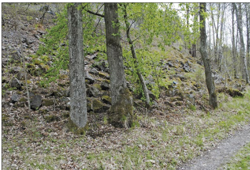
Figur 22. Bilden visar den stensatta banvallen, den s.k. Storängsbanken. Foto från nordväst.
