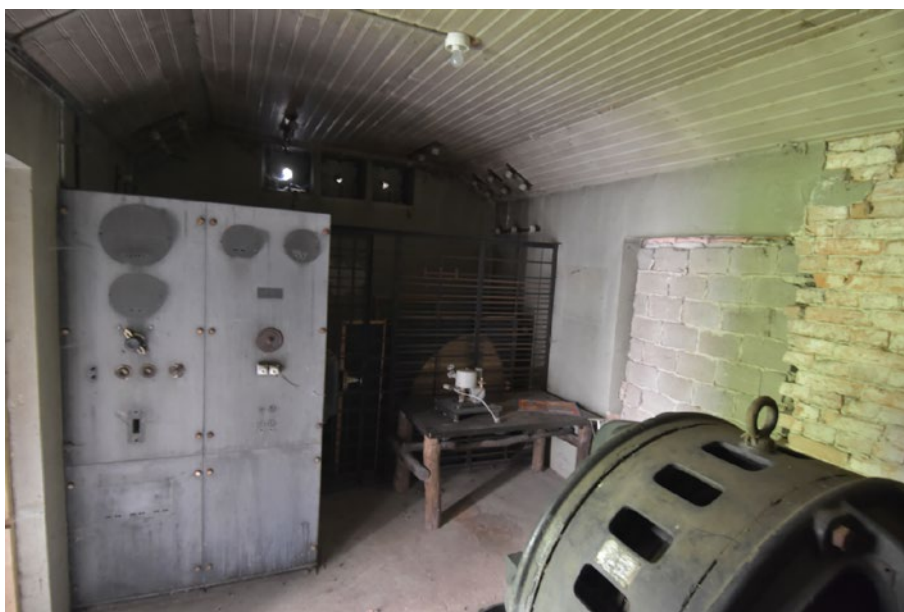
Generatorbyggnaden med generatorn till höger. Rakt fram i bild manöverpanelen med spår av mätare och brytare. Bakom denna gallerförsedda skåp för transformatorerna.
