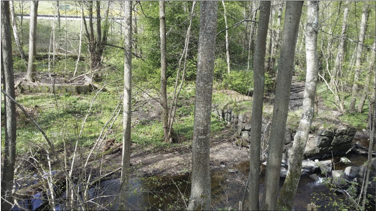
Figur 14. Miljön vid ravinens sydligaste del, nr 1 och 2. Bilden visar brofundamentet som övergår till väg samt husgrunden. Foto från öster.
