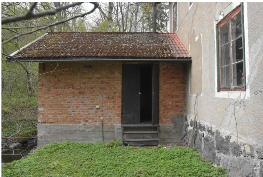
Generatorhuset från öst. Denna del är murad i tegel över en betonggrund, till höger huvudbyggnaden med köksfönstret.
