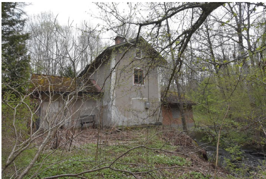
Kraftverksbyggnaden från väst. Till vänster verkstadsdelen, i mitten byggnadens huvudkropp i två våningar och till höger generatorhuset.
