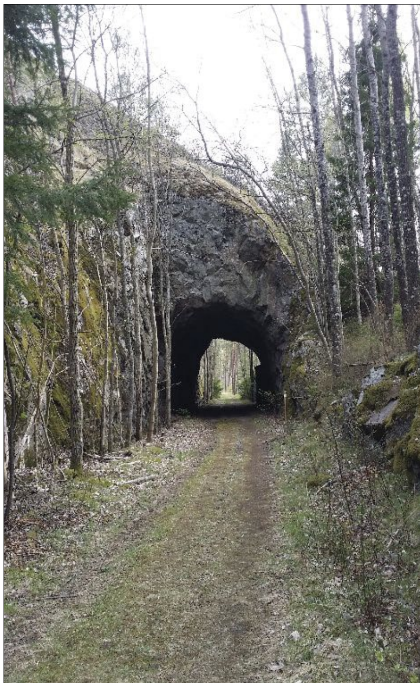
Figur 8. En tunnel sprängd i berget för järnvägsspåret. Foto från norr.
