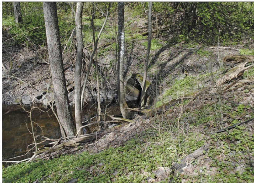
Figur 15. Kulvertens utlopp i söder. Foto från öster.
