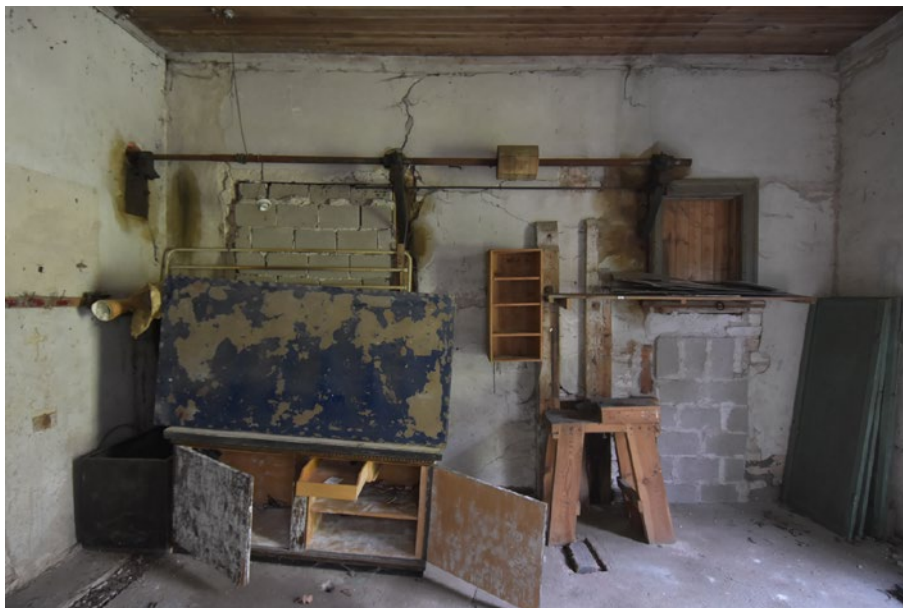
Verkstaden. I taket går en drivaxel för remdrivna maskiner.
