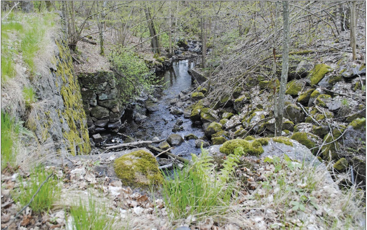
Figur 26. Lämningar efter Stens bruk ligger i den nordligaste delen av utredningsområdet. Bilden visar den lodräta väggen av sten till vänster, där järnkrampor med årtalet 1854 är inslagna. På den plana ytan längst till vänster i bild har en byggnad stått som tillhört bruket. Foto från norr.
