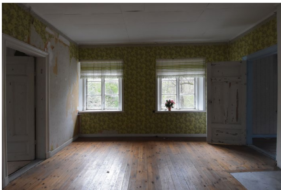
Det östra större rummet på övre plan. Golvet är troligen sekundärt liksom skivmaterialen i taket. Notera väggens läge i förhållande till fönstret. Läget antyder att planlösningen inte är ursprunglig.
