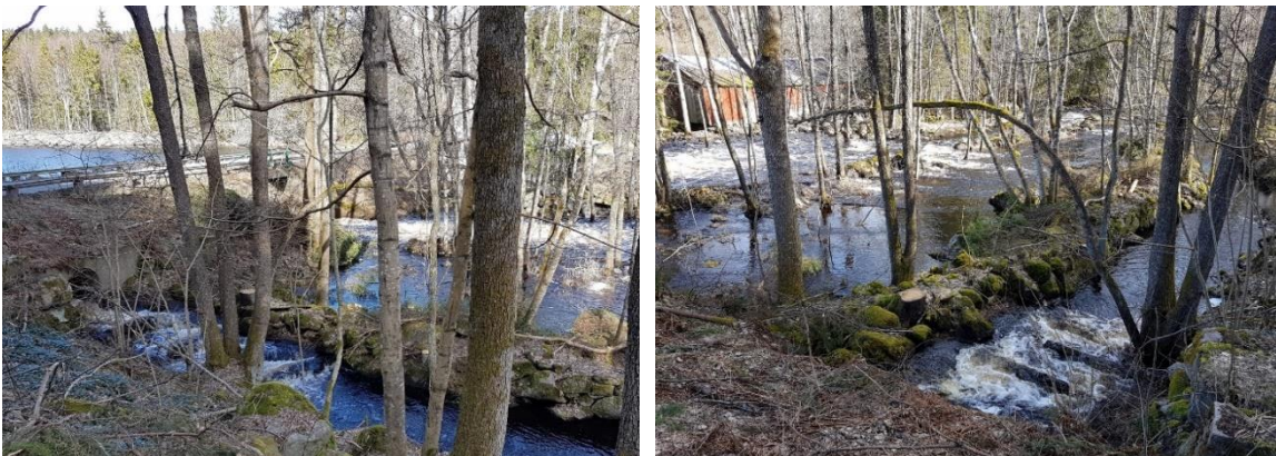
Figur 6a och b. Från dammanläggningen forsar vattnet ner i åns sträckning inom naturreservatet. Det finns en trumma och trappa för fiskpassage vid den västra sidan.
