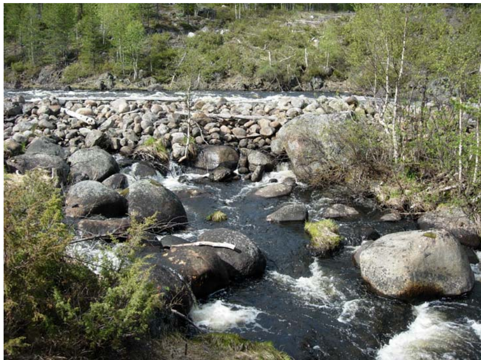
Bild 1. Under flottningsperioden lades Malåns södra lopp igen med grov sten. (Bilden är tagen under snösmältningsperioden.)
