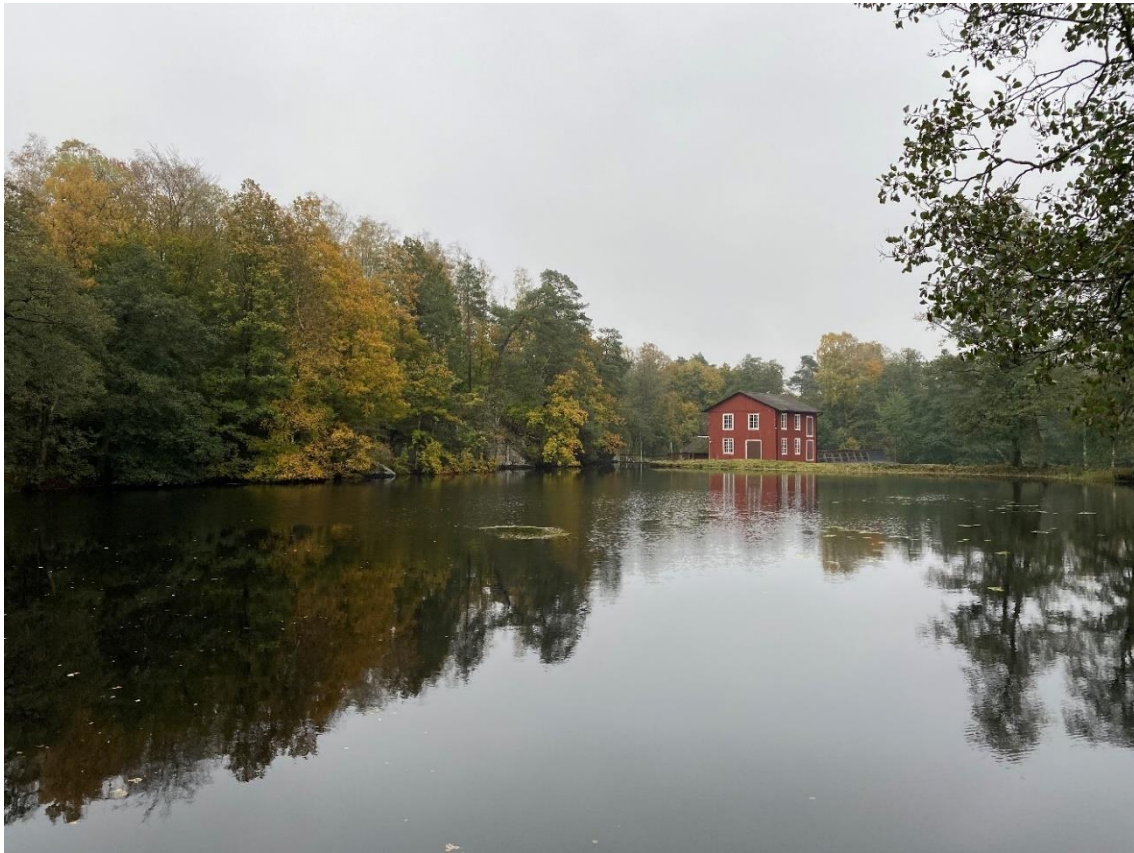
Figur 29. Knobesholms kraftverk med del av dammen i förgrunden.
