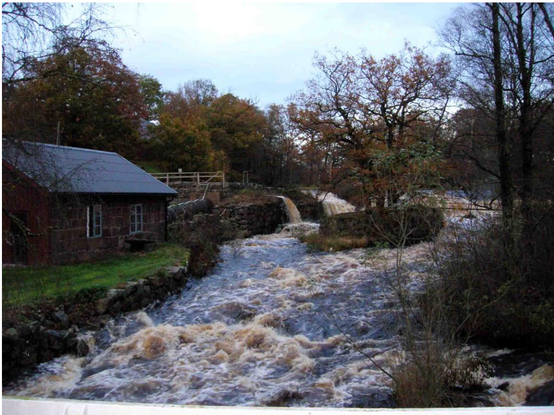
Figur 25. Mostorps kraftstation och fd kvarn. Foto: Christina Svantesson, Kulturmiljö Halland, 2006.
