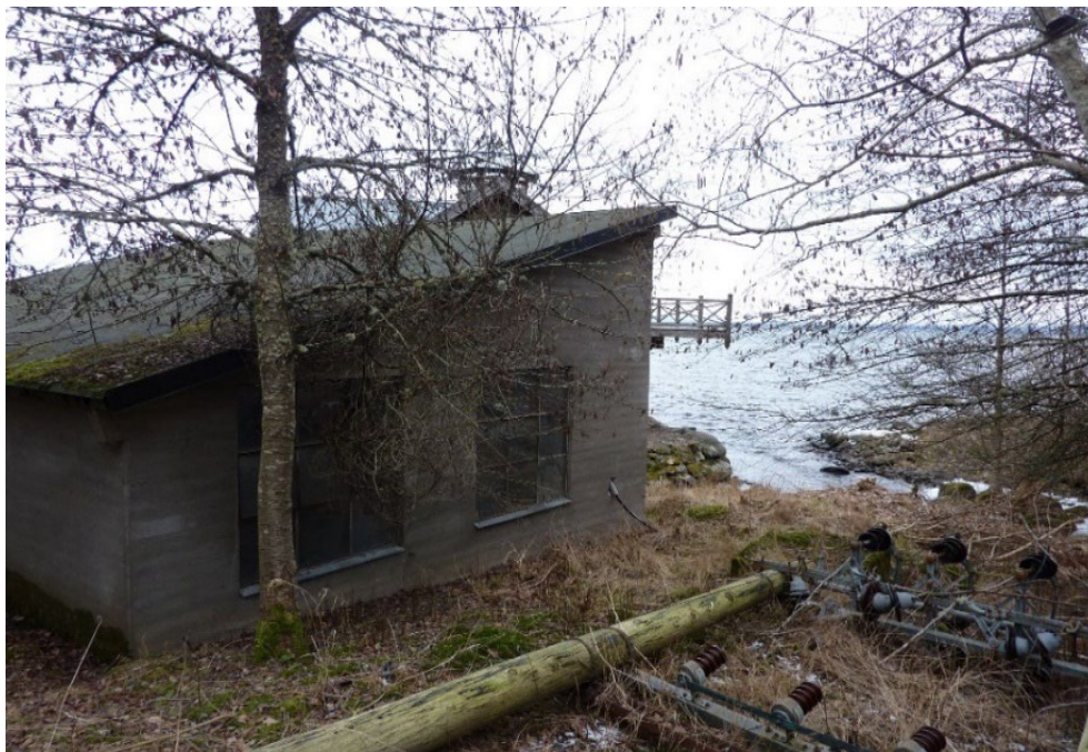
Figur 15. Häldeholms nya kraftstation från 1946, vid Holmåns mynning i Vättern.
