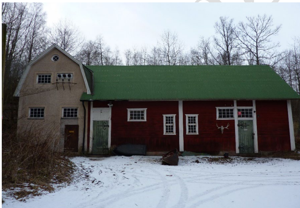
Figur 16. Hälsdeholms gamla kraftstation från 1915 med tillbyggnad från år 1929. Inkommande tub från den övre dammen/dammarna passerar under den gamla kraftstationen ner mot Vättern och den "nya" kraftstationen vid Vätterns strand.
