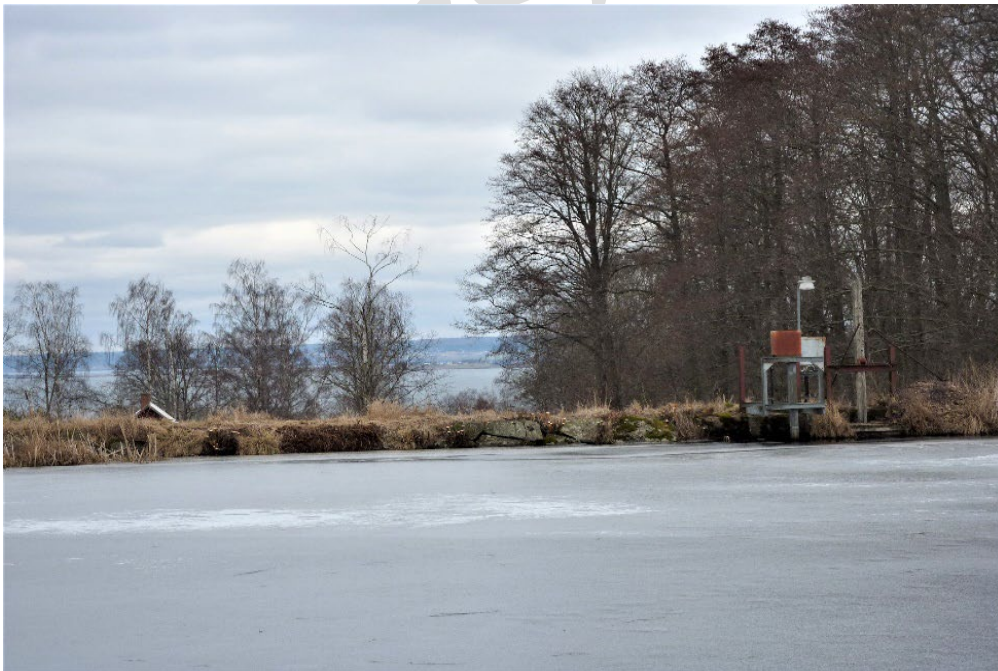
Figur 14. Häldeholms norra del av dammen med utskov och utloppstub ner mot Häldeholms gård och kraftstationen vid Vättern. Vättern och Visingsö skymtar i öster.
