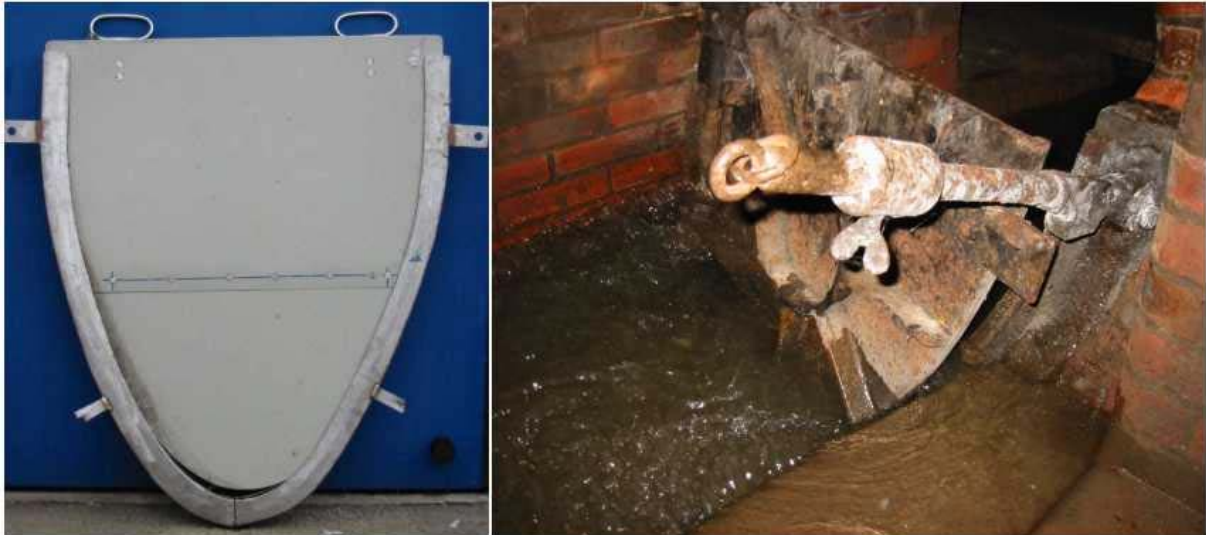
Bild A13: Handzugschieber und halbautomatische Spültür der Stadt Frankfurt
