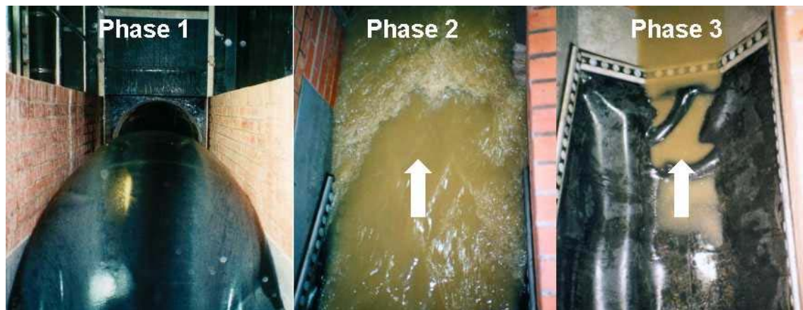
Bild 4.14: Betriebsphasen eines Schlauchwehres
