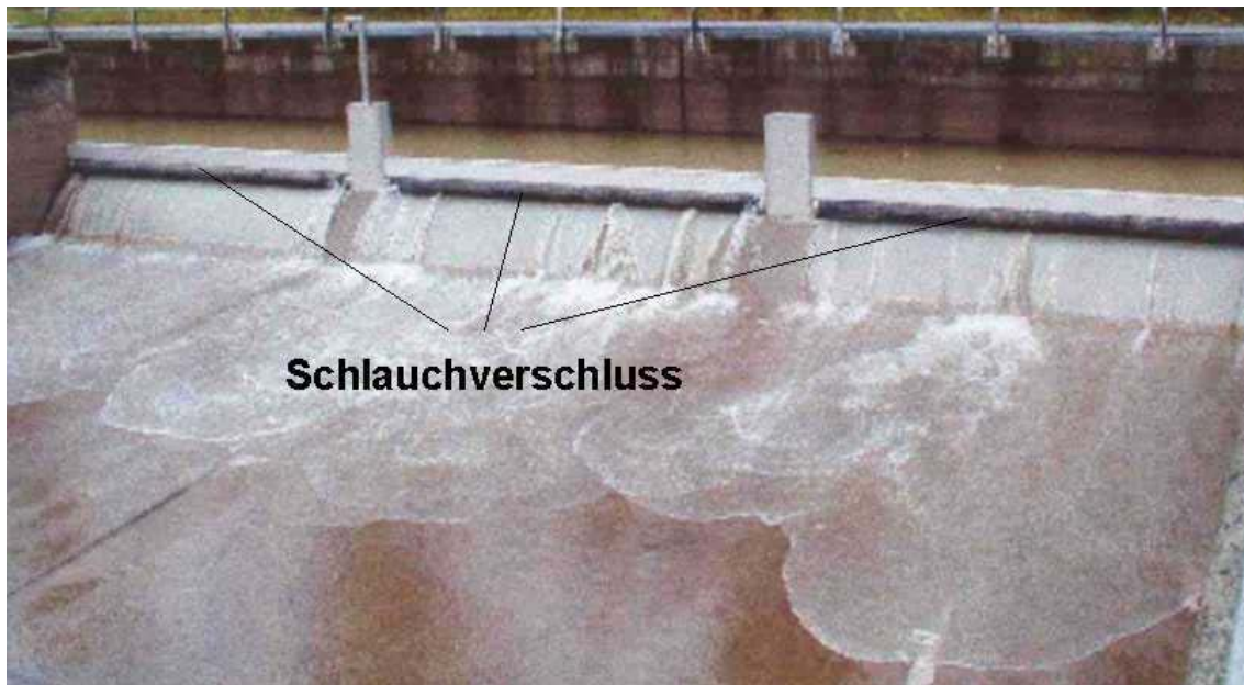
Bild 4.15: Einsatz einer schlauchartigen Reinigungseinrichtung in einem Regenbecken (nach WILLEMS, 2002)
