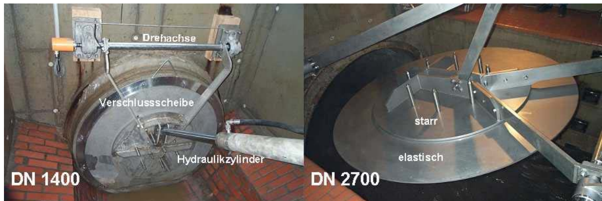
Bild A10: Stau- und Spülklappen der Rotaria PG (KOTZBAUER, 2002)
