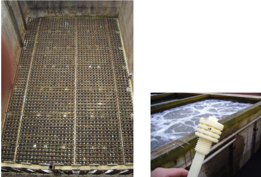
Abbildung 6 Blick in den GA (links) vor der Befüllung mit Aktivkohle und auf eine der eingebauten Filterdüsen (rechts)
