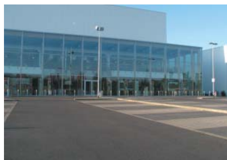
Großzügige Flächenversiegelung in Gewerbegebiete.
