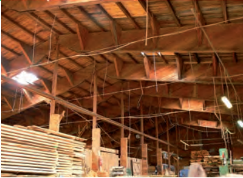
Drewniana konstrukcja dachu hali zagnańskiego tartaku
