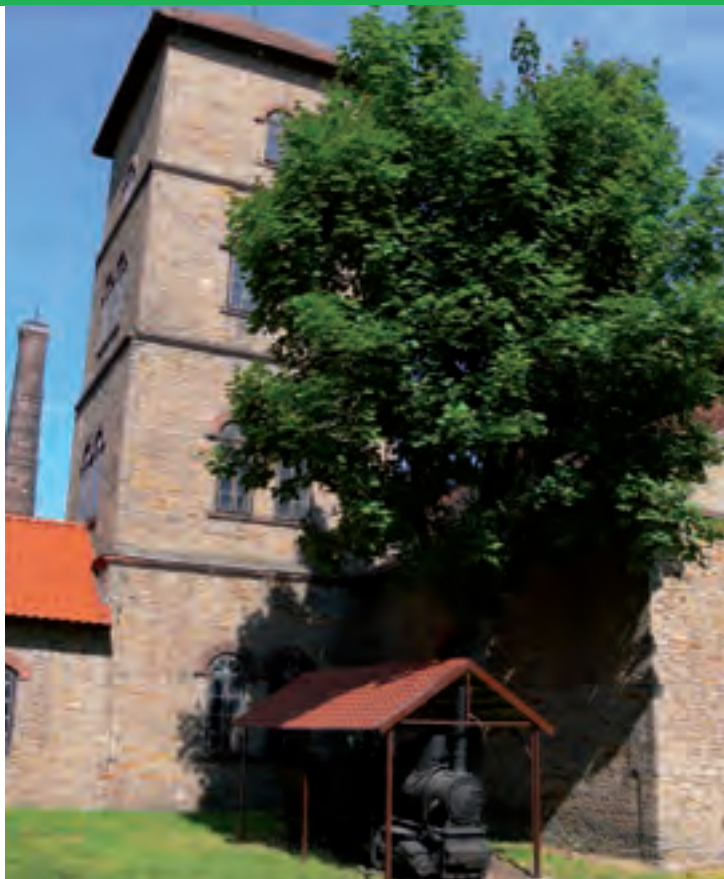
Chlewiska, wieża gichtociągowa dawnej buty
