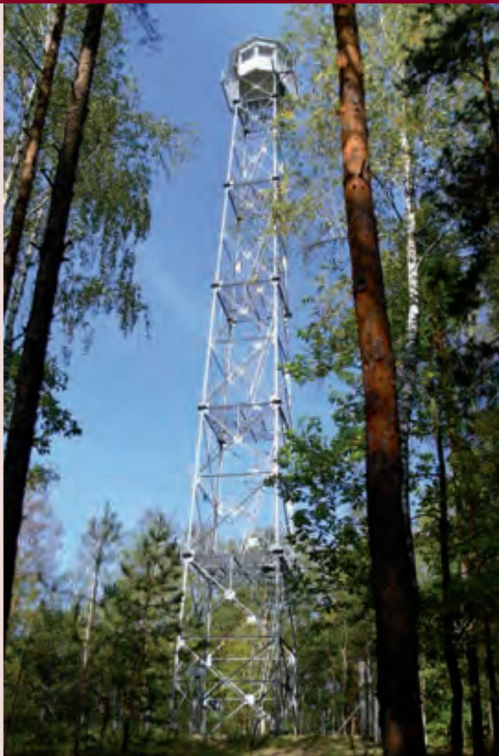
Wieża dostrzegalni przeciwpożarowej na Wielkiej Górze
