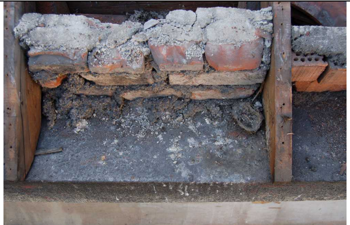
2 Mauersegler-Napfnest im Dachfuß
