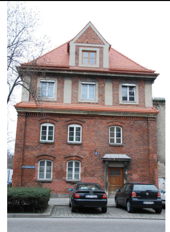
6 Gebäude nach der der Sanierung
