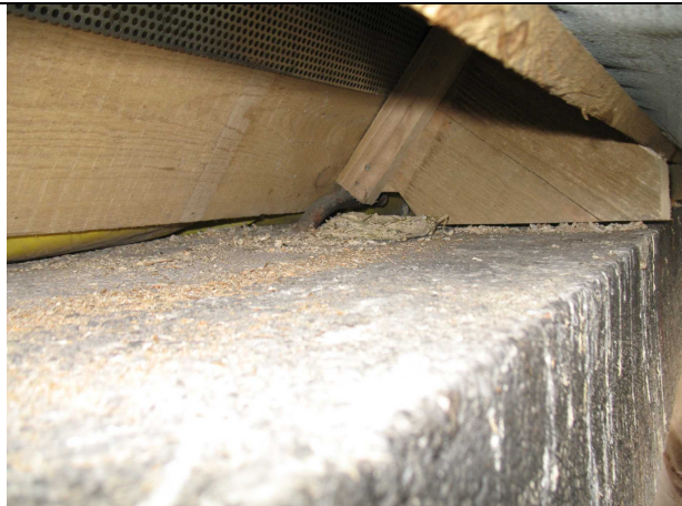
3 Nach dem Umbau: Abtrennung des Brutraumes zur Dachdämmung hin
