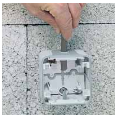
Kabel einführen
