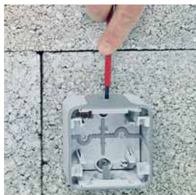
Durchstoßen der Membraneinführung mittels Schraubendreher
