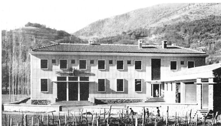
Figura 5. Fachada do prédio externo do Laboratório Subterrâneo de Moulis (França), onde estão a biblioteca, as salas dos pesquisadores e laboratórios adicionais.
