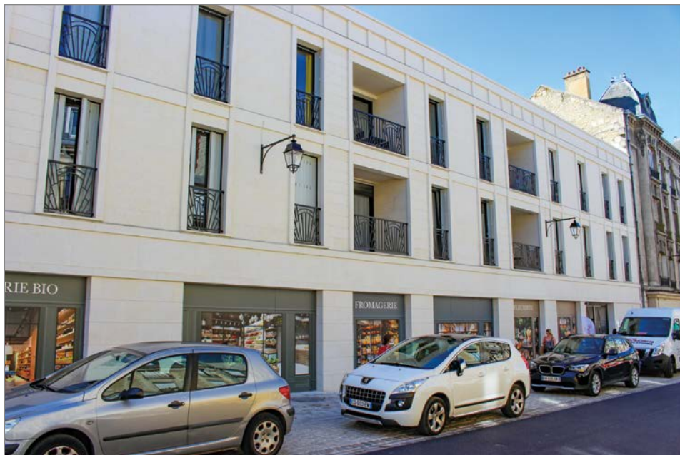
Entièrement reconstruite, la nouvelle résidence de la Croix d'Or n'est plus « la dent creuse » de la rue Saint-Christophe.
