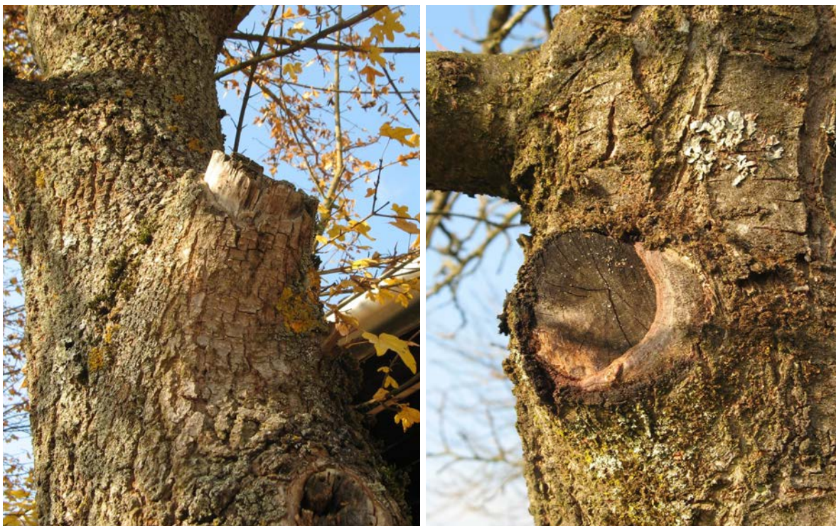
Abb. 19: Links ein Feldahorn mit falsch durchgeführten Schnitten. Die ca. 10 cm (ganz unten) und 20 cm langen Aststümpfe konnte der Baum nicht überwallen. Sie faulen in den Stamm hinein. Standfestigkeit und Vitalität sind gemindert. Rechts ein falscher Schnitt an einer Zwetschge. Er wurde nicht quer zur Längsachse durchgeführt. Die Überwallung des ca. 4 cm langen, schräg gesägten Stummels dauert zu lange.
