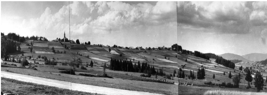
Abb. 4: Bischofsreut 1937 mit gehölzärmer Ortsflur (Südostansicht) 2
