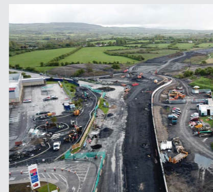
Oibreacha tógála ar Bhóthar Dáileacháin ó Uí Chuanach go Cnoc an Lísín
