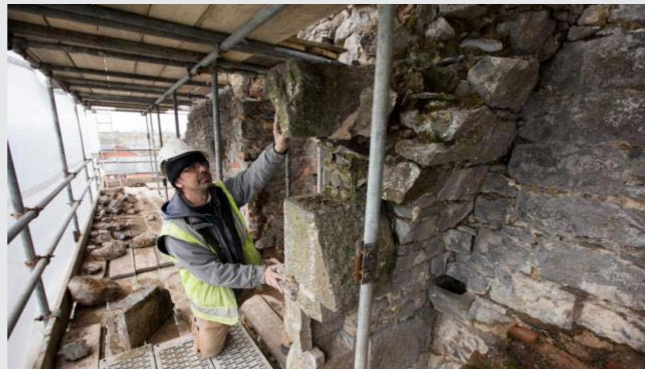
Saor cloiche ag obair ar Láthair an Tinteáin le linn Chéim 1 de na hOibreacha Cobhsaithe i 2017
