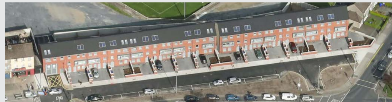
Rae Radharc na Páirce: Athchóiriú ar iar-Árasáin Bhóthar de hÍde ag soláthar 20 aonad nua.
