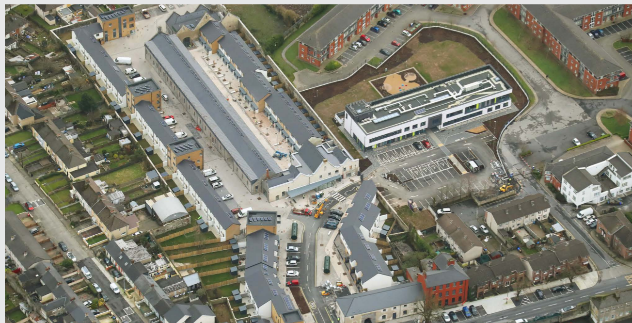
Radharc ón aer ar an bhForbairt Tithíochta nua ag Sráid an Tiarna Éadbhard, mar a bhfuil 81 aonad leithdháilte sa bhforbairt seo.
