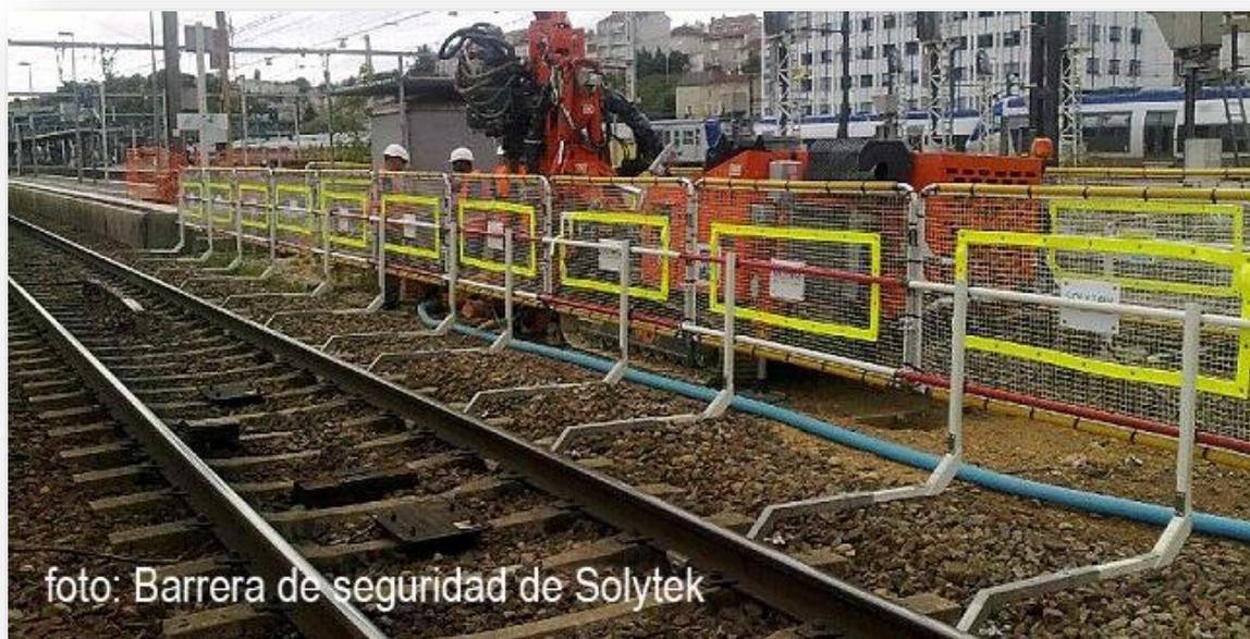
La característica por la que se considera una barrera física que separa a trabajadores y máquinas de las circulaciones, es la que permite poder ejecutar trabajos que con los otros sistemas de vallas de señalización sería imposible acometer si antes no se interrumpe la circulación de los trenes.
