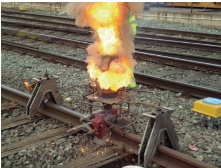
Imagen 2.26. Soldadura Aluminotérmica. Fuente: TECSA
