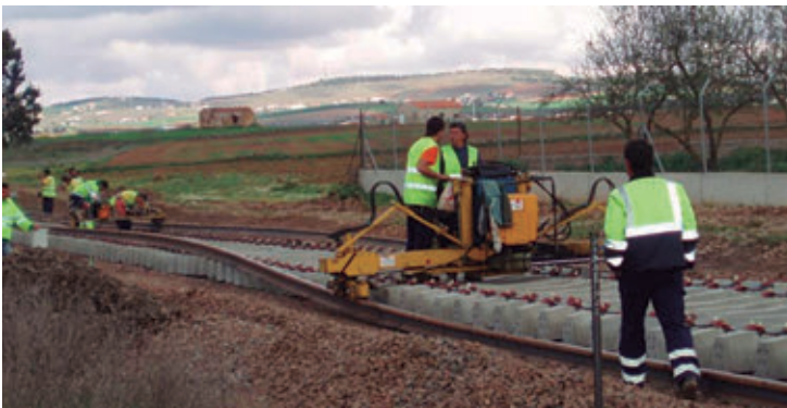
Imagen 2.19. Posicionadora de carril. Fuente: VIAS
