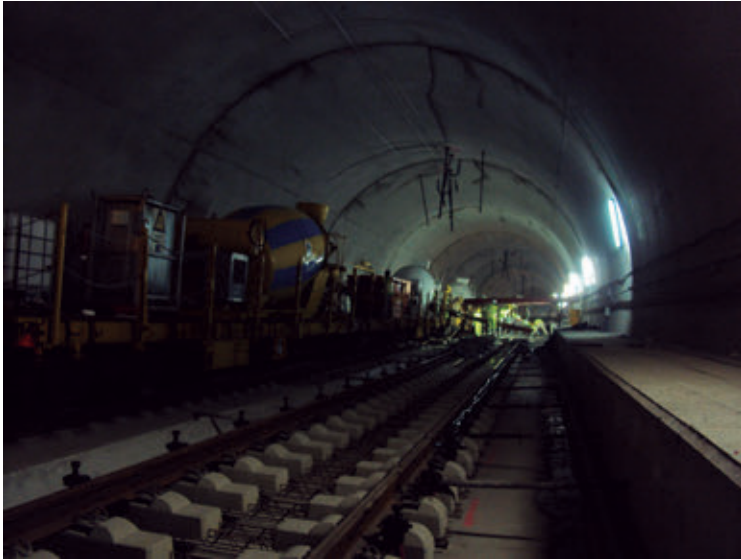
Imagen 2.35. Trabajos en interior de túnel. Fuente: TECSA
