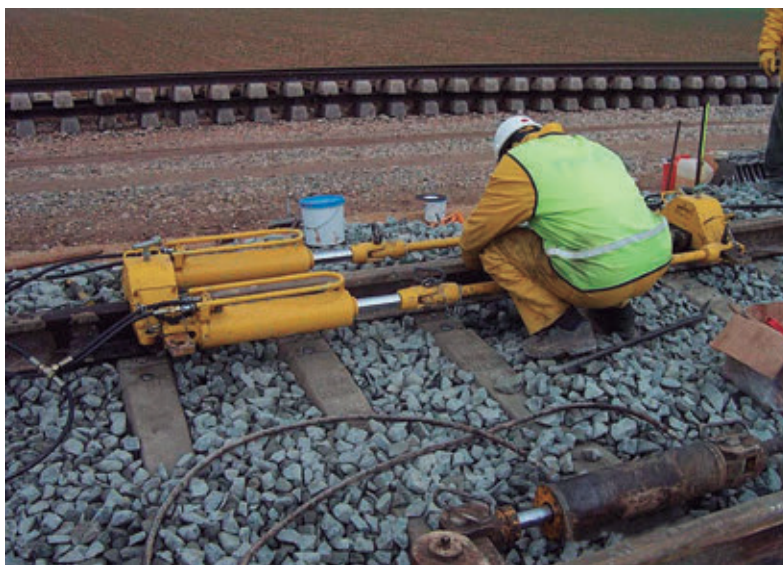
Imagen 2.18. Liberación Tensiones. Fuente: VIAS
