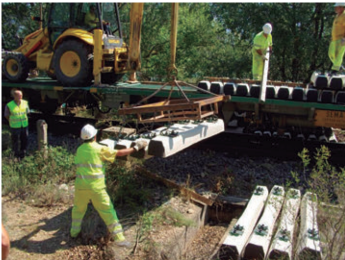
Imagen 3.10. Elementos de elevación. Fuente: COMSA
