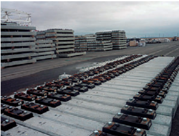
Imagen 2.8. Acopio de traviesas. Fuente: COMSA
