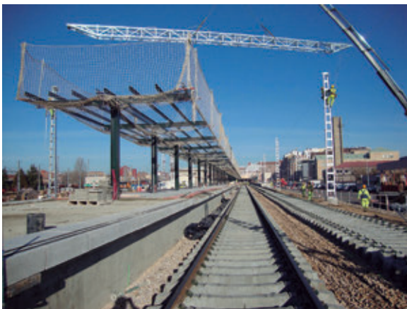
Imagen 2.31. Montaje pórtico de catenaria. Fuente: COMSA
