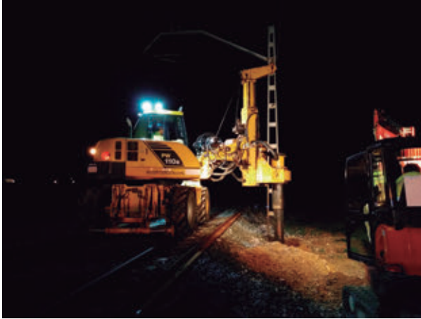
Imagen 2.30. Colocación de poste de catenaria. Fuente: TELICE
