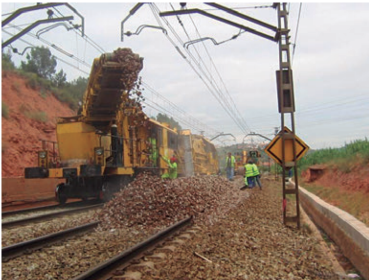
Imagen 3.7. Desalojo de material con desguarnecedora. Fuente: COMSA
