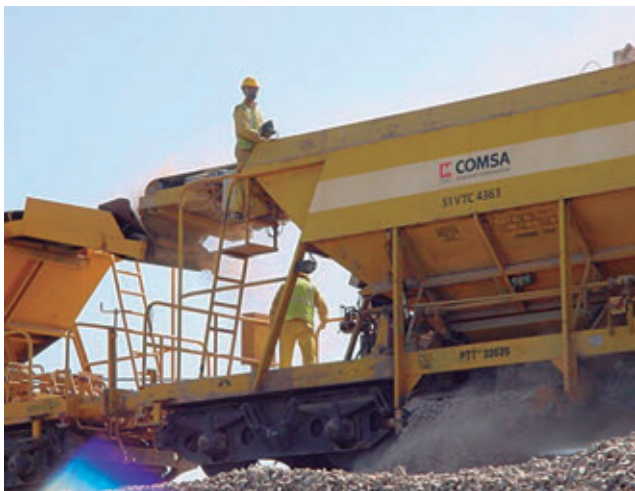
Imagen 3.1. Acceso en altura a tolva de balasto. Fuente: COMSA
