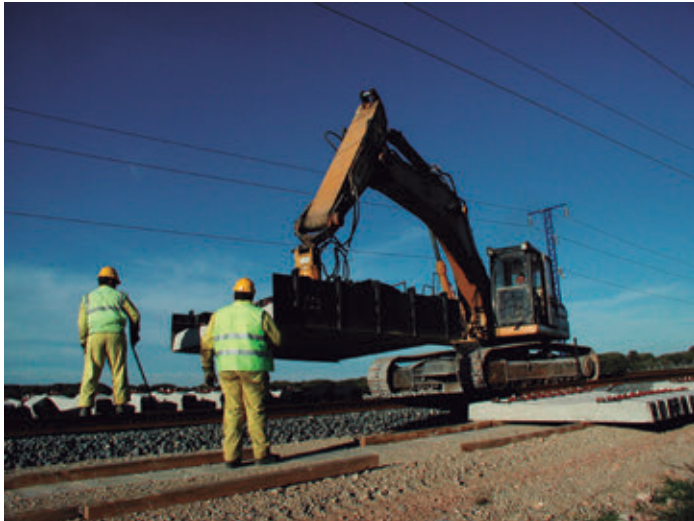
Imagen 2.11. Montaje de traviesas. Fuente: VIAS
