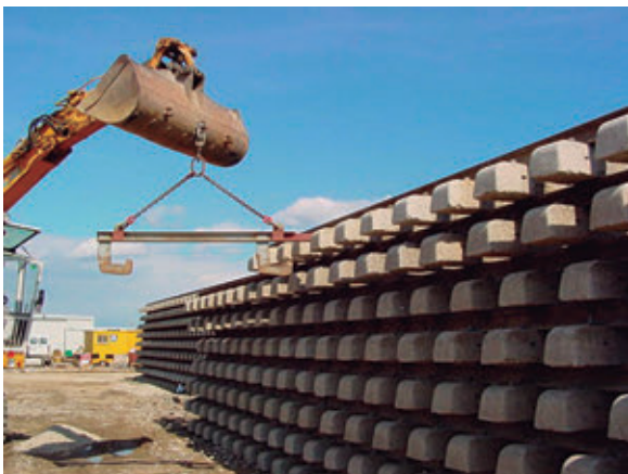
Imagen 3.2. Acopio en altura.
