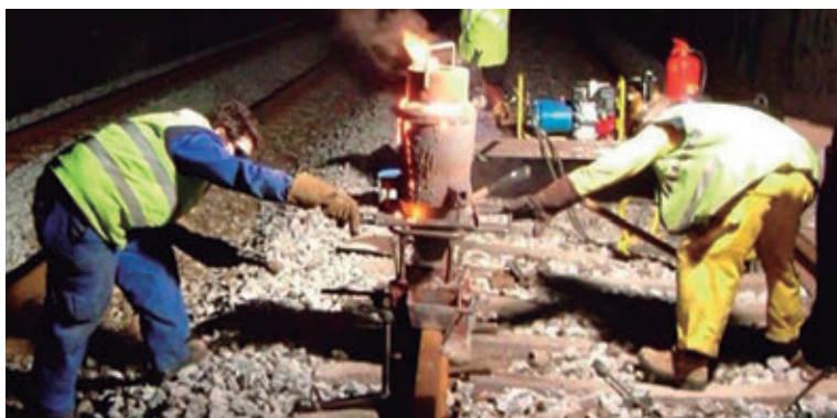
Imagen 3.9. Soldadura aluminotérmica. Fuente: COMSA
