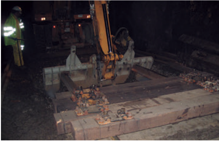
Imagen 2.34. Cambio de traviesas en interior de túnel. Fuente: COMSA
