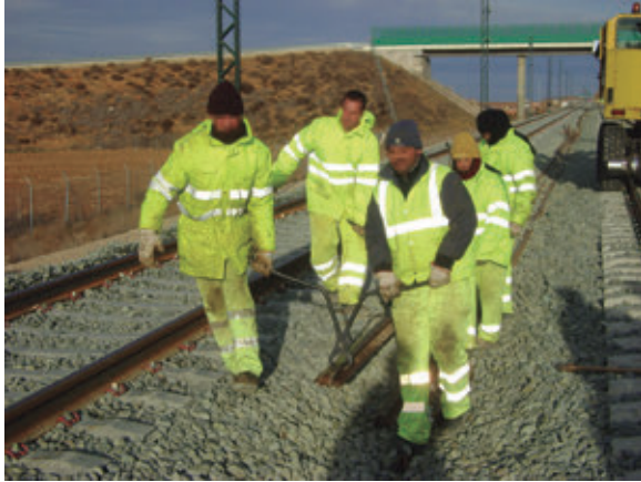
Imagen 2.18. Manipulación manual de tramo de carril. Fuente: VIAS
