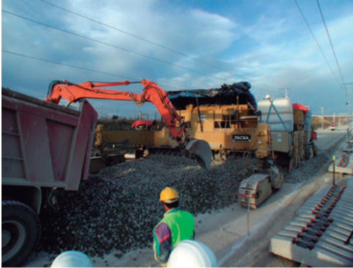
Imagen 2.3. Extendedora de balasto. Fuente: TECSA
