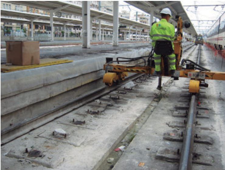
Imagen 2.29. Vía en Placa. Fuente: FLC
