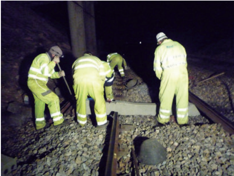
Imagen 5.3. Trabajadores en el interior de la vía. Fuente: FLC
