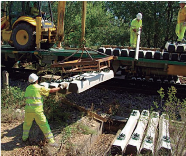
Imagen 2.10. Descarga de traviesas. Fuente: COMSA
