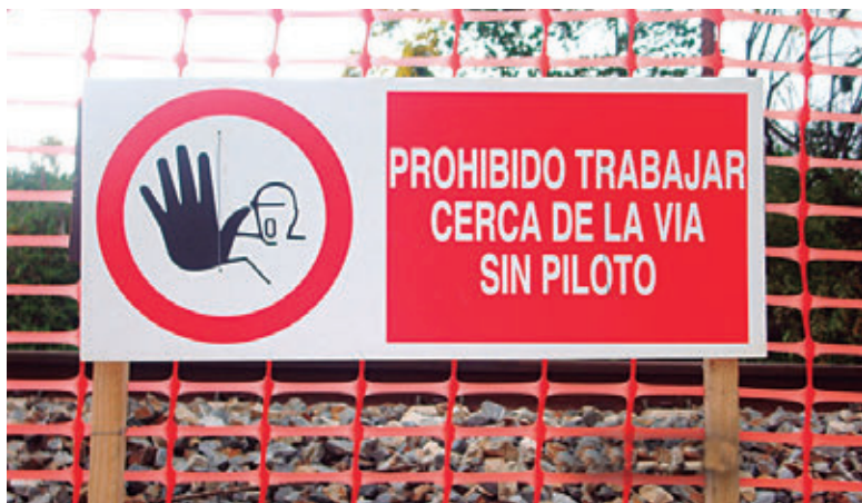
Imagen 5.4. Señal de prohibición de trabajos. Fuente: Daniel Sánchez Polo
