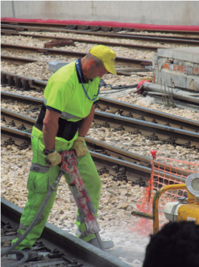
Imagen 3.25. Trabajo con martillo neumático. Fuente: FLC
