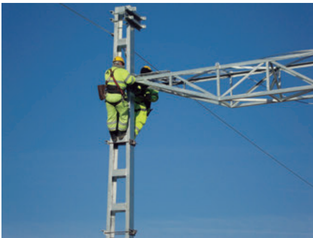
Imagen 3.17. Trabajos con riesgo eléctrico. Fuente: COMSA
