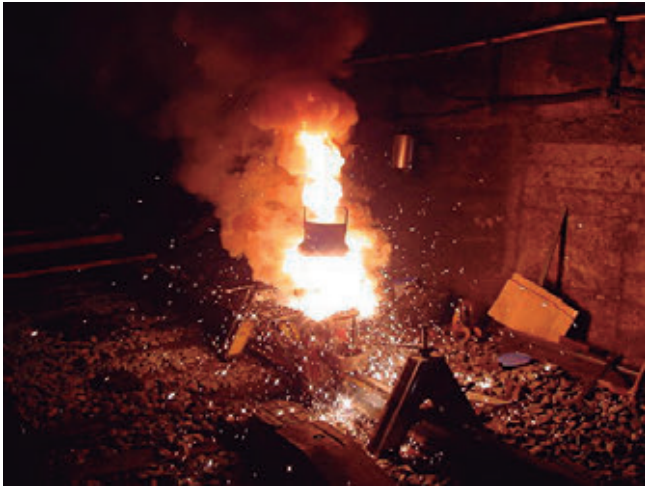
Imagen 3.22. Soldadura aluminotérmica. Fuente: COMSA
