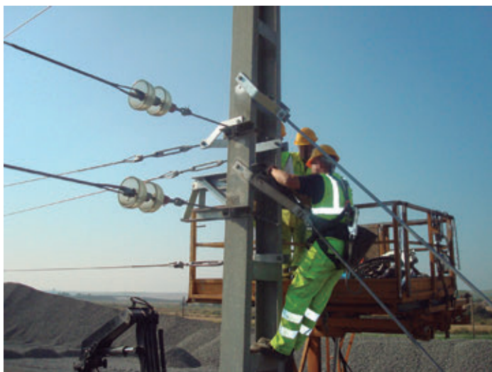
Imagen 6.11. Trabajos en catenaria. Fuente: COMSA
