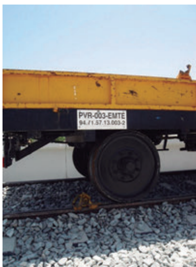
Imagen 5.9. Colocación de calces. Fuente: COMSA
