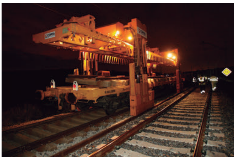
Imagen 2.13. Pórtico descarga de traviesas. Fuente: COMSA
