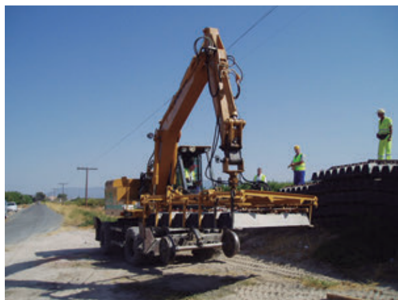
Imagen 2.1. Descarga de materiales. Fuente: VIAS
