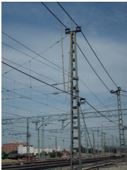
Imagen 6.9. Pértigas de puesta a tierra. Fuente: VIAS
