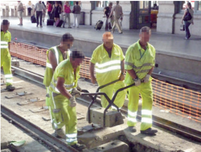
Imagen 3.5. Colocación manual de bloque de traviesa. Fuente: FLC
