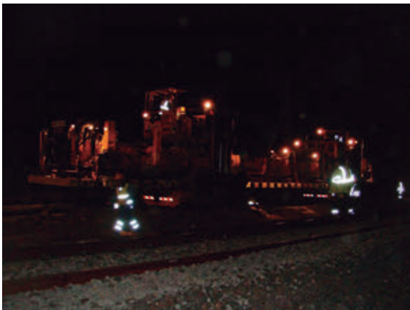
Imagen 5.8. Movimiento de avance de vehículo ferroviario en trabajo nocturno. Fuente: COMSA
