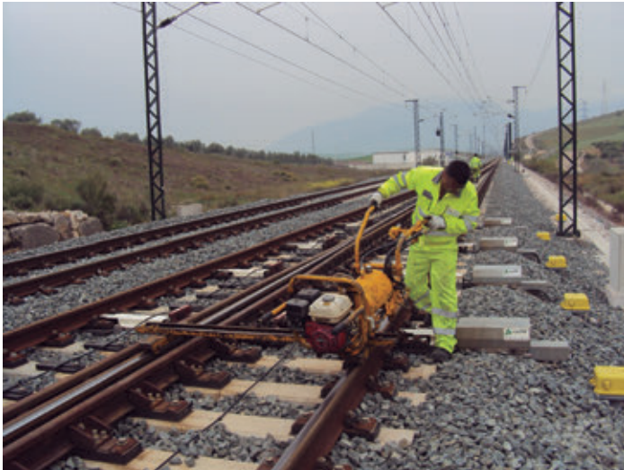
Imagen 2.20. Motoclavadora de carril. Fuente: TECSA
