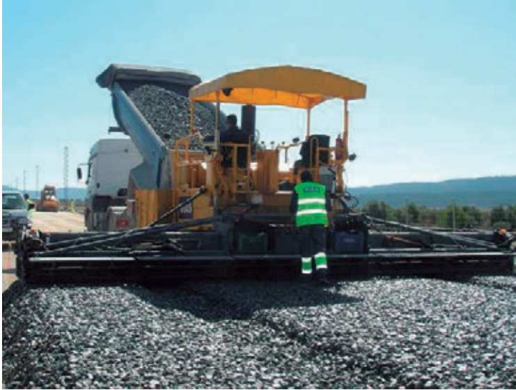
Imagen 2.2. Aporte de balasto sobre extendedora. Fuente: VIAS
