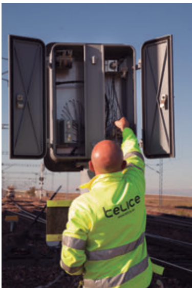
Imagen 2.32. Revisión instalaciones de seguridad. Fuente: TELICE
