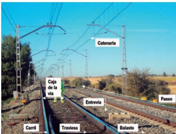
Imagen 5.1. Elementos de una vía ferroviaria. Fuente: VIAS
