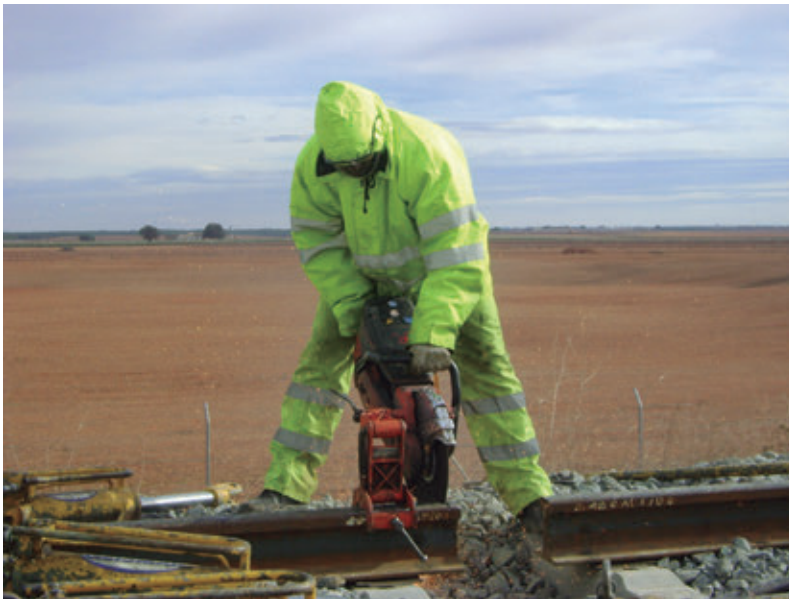
Imagen 3.8. Corte con tronadora. Fuente: COMSA
