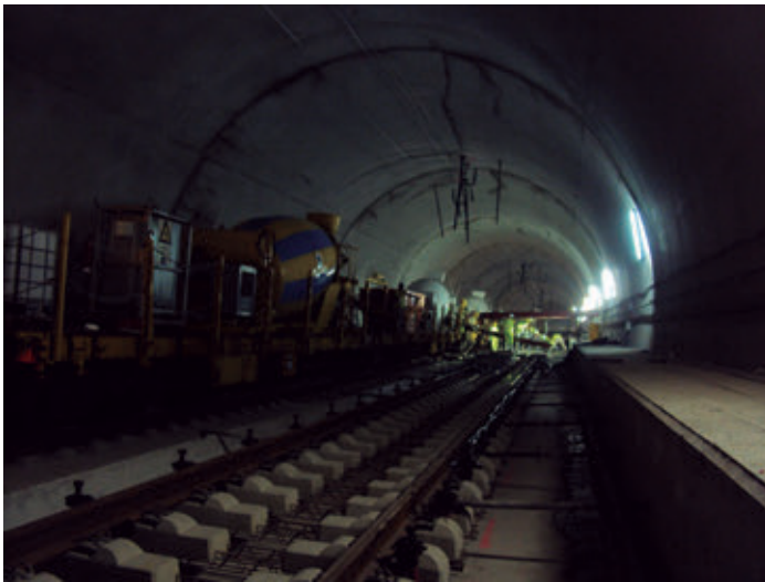
Imagen 2.36. Trabajos nocturnos. Fuente: TECSA
