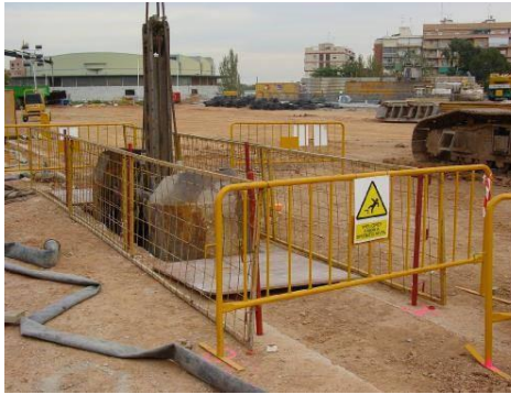
Imagen 10. Vallado durante ejecución de
