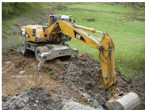
Imagen 26. Retroexcavadora de neumáticos con estabilizadores extendidos para evitar el riesgo de vuelco.
