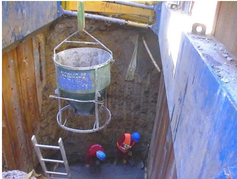
Imagen 23: Hormigonado con cubilote.
