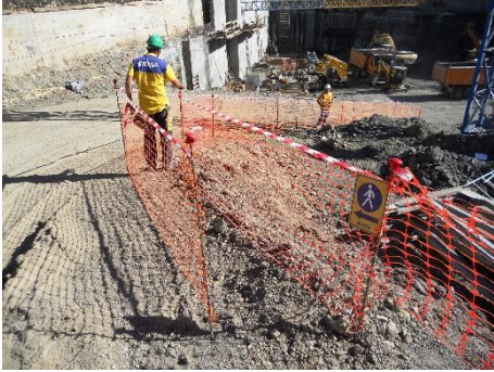
Imágenes 35 y 36: Paso de peatones por vía perfectamente señalizada y diferenciada para evitar atropellos
