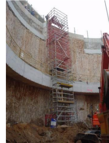
Imagen 19. Trabajo en pozos de grandes dimensiones.
