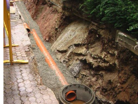
Imagen 24: Relleno de recubrimiento.
