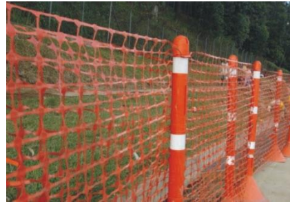
Imagen 3. Malla tipo stopper y varillas de delimitación
