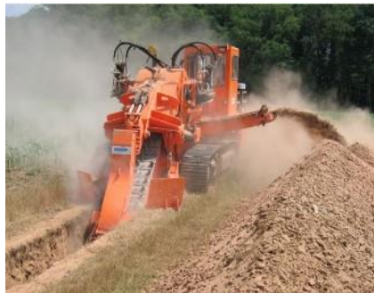
Imagen 15: Zanjadora en ejecución.
