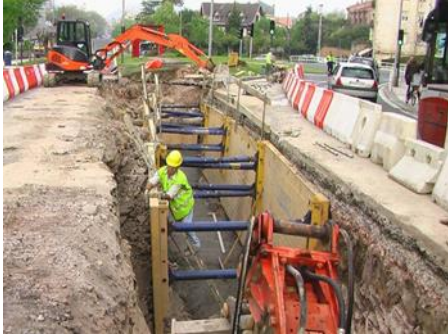
Imagen 21. Trabajos de entibación
