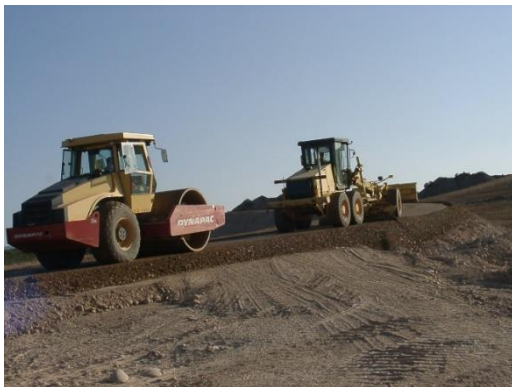
Imagen 10. Extensión y compactación del material en tongadas Utilización de maquinaria pesada.
