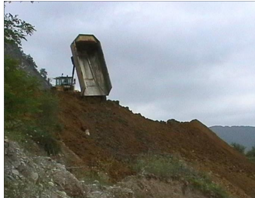
Imagen 38: Precaución al posicionar el camión al borde de talud, por cambio de presión de ruedas anteriores y posteriores, antes y después de la
