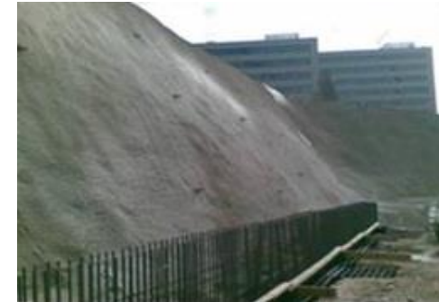
Imagen 5. Gunitado de taludes
