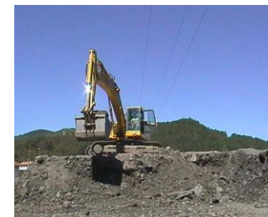
Imagen 27: Carga con rodajes paralelos al borde de talud
