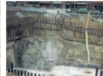
Imagen 9. Contención con perfiles/carriles
