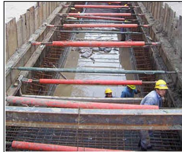
Imagen 11. Tablestacas atirantadas
