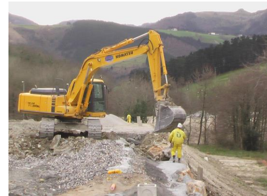
Imagen 25: Retroexcavadora en funcionamiento
