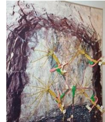
Imagen 11: conexión de detonadores no eléctricos
