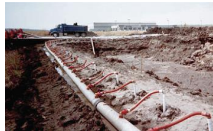
Imagen 3. Aplicación en zanja.
