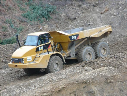
Imagen 31: Bajada de pendiente.
