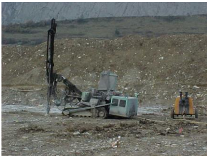
Imagen 13. Perforadora de barrenos.
