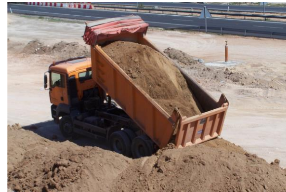
Imagen 39: Descarga de material con camión basculante sobre capa en ejecución.
