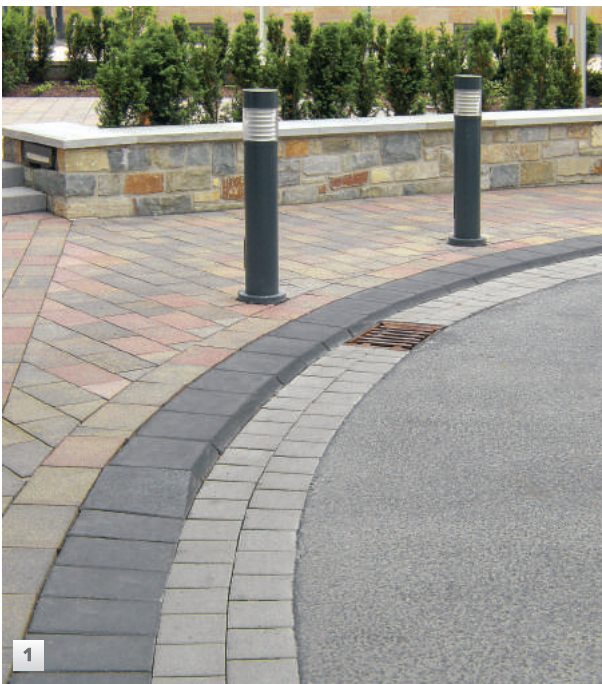
1 – Breitbord mit Absenker auf Pflasterstein 30 x 30 cm, basalt-anthrazit 2 – Breitbord, granit-braun
