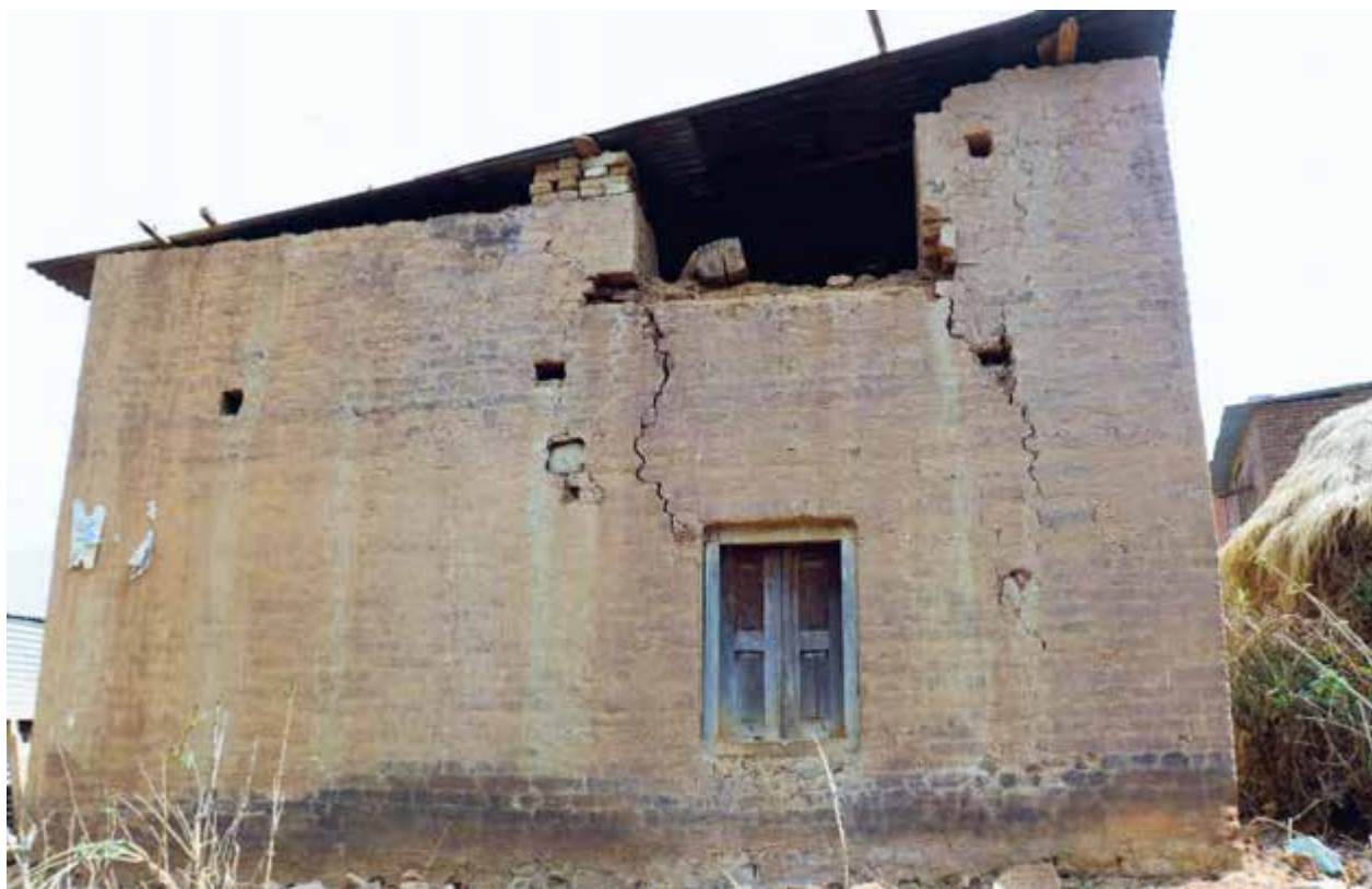
Eine Kindheit in Trümmern. Die tiefen irreparablen Risse im Gebäude sind gut zu sehen, dennoch wurde das einsturzgefährdete Haus notdürftig repariert. Als Alternative bleiben vielen Menschen nur Behelfsunterkünfte aus Wellblech und Zweigen.
