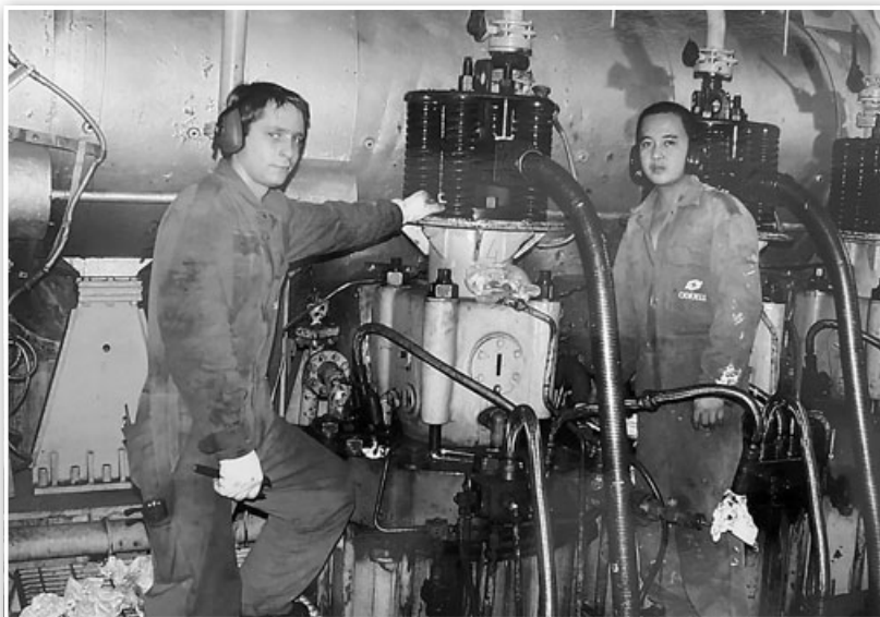
Kuģa mehāniķis Edgars Gļauņenko kuģa galvenā dzinēja remonta procesā.
