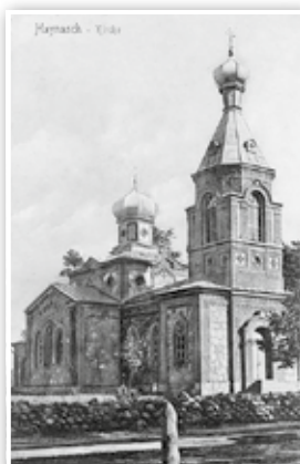
Ainažu pareizticīgo baznīca. Būvēta 1894. gadā.
