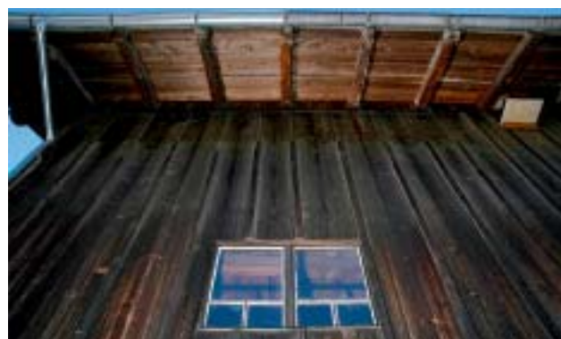
Abb. 72 An dieser Scheune in Mauren lebte im heissen Sommer 2003 eine Wochenstubenkolonie im Zwischenraum des Vordachs. (Foto: Silvio Hoch)
