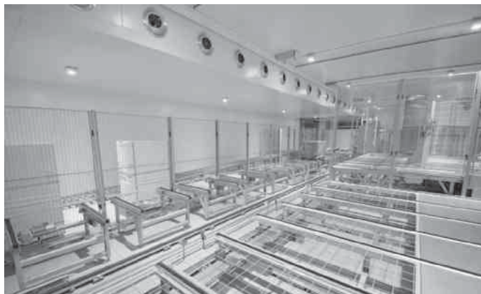
Im Bereich der Kommissionierung werden kundenspezifische Paletten zusammengestellt.
