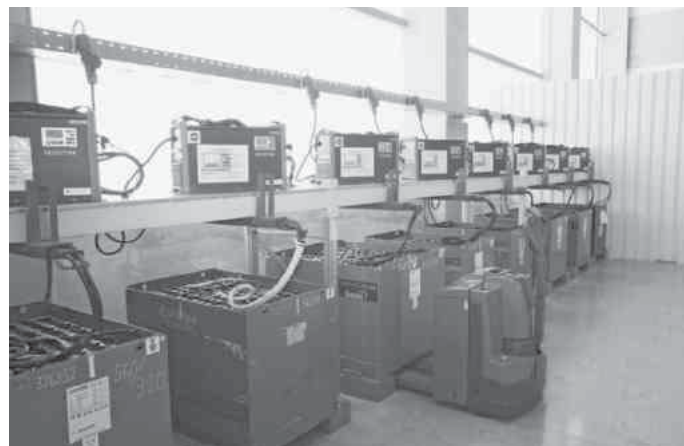
Der innovative Ri-Ladeprozess der Fronius-Geräte reduziert die Überladung der Batterie auf ein Minimum. Das senkt den Energieverbrauch beim Laden und verringert den CO 2 -Ausstoss.
