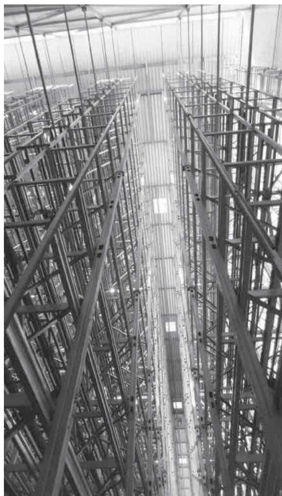
Rittals neues Hochregallager am Standort Haiger verfügt über eine Gesamtkapazität von 25 000 Palettenstellplätzen. (Fotos von Kocher Regalbau)
