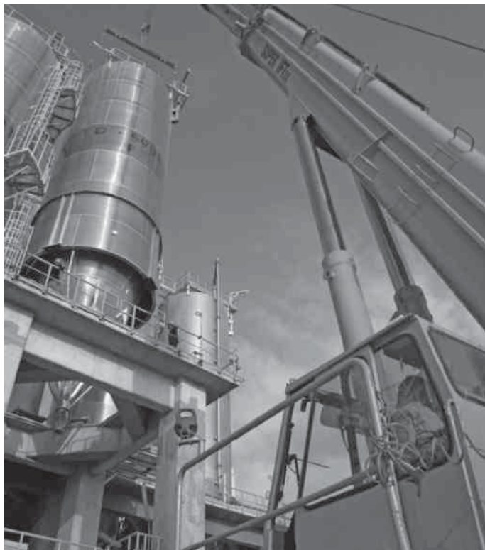
Abb. 1: Sind Wägemodule in Tragwerken aus Stahl oder Aluminium verbaut, müssen auch diese gemäss den Anforderungen der EN 1090 gefertigt sein, also die entsprechende CE-Kennzeichnung aufweisen.
