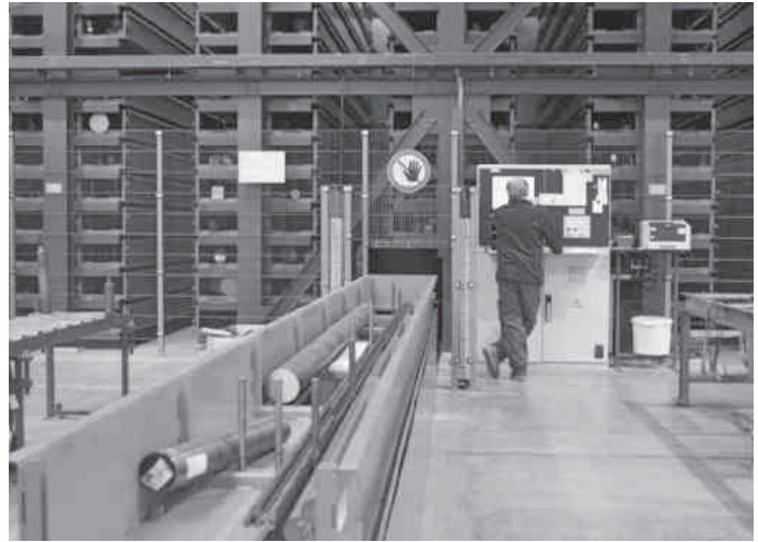
Das Lager ist an das unternehmensweite ERP-System von SAP angebunden. Die Ein- und Auslagerbefehle erfolgen über die Bedienpulte direkt in SAP.
