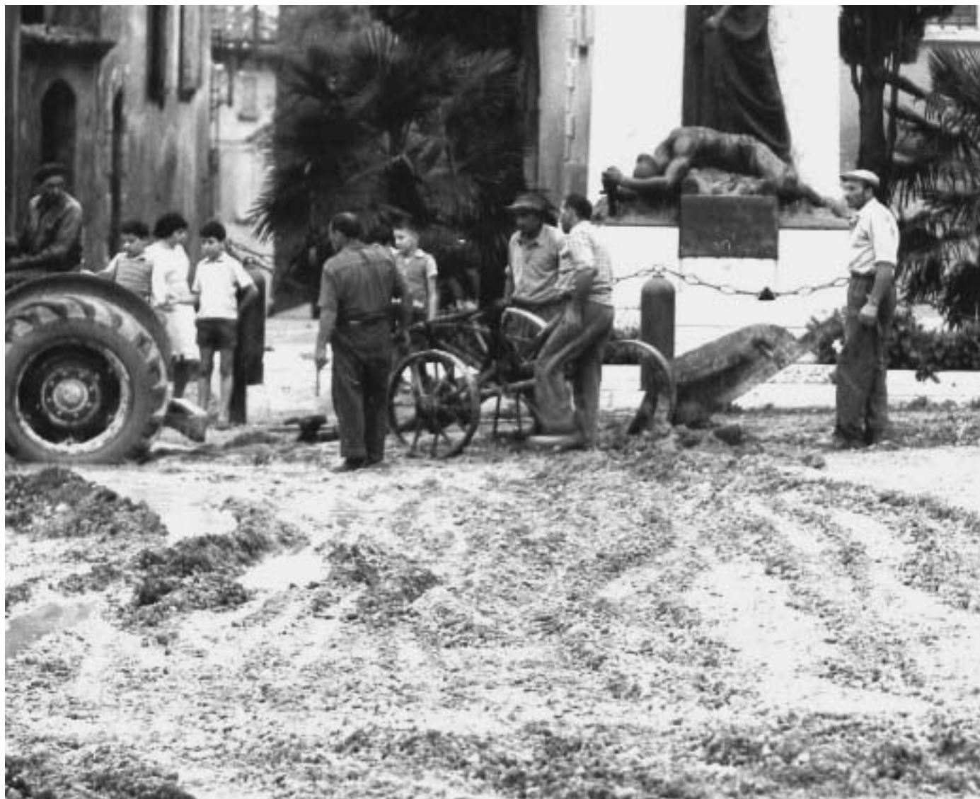
1958 circa. Lavori preparatori per la pavimentazione della Piazza Municipale.
