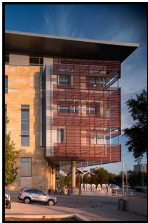
El aluminio anodizado perforado es un elemento de diseño central de la fachada en la biblioteca central recientemente construida en Austin, Texas. Fotografía:
