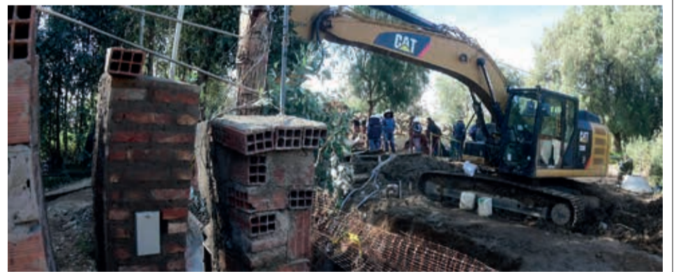
Postes de medidores inclinados por obras para la planta de Tiquipaya. CARLOS LÓPEZ
