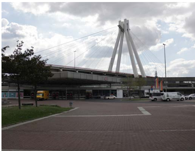
Blick auf die Pylon-Brücke
