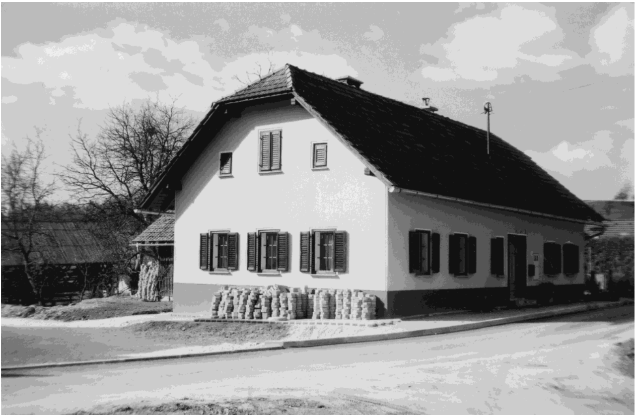
Mihčeva lepo obnovljena kmečka hiša.
