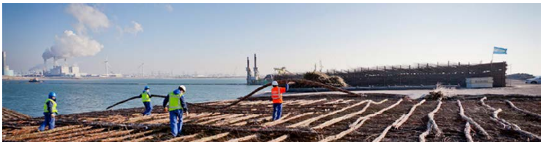
Abb. 50: „Zinkstukken“ und Faschinen sind auf der Erweiterung der Maasvlakte (Europoort) in den Jahren 2011 und 2014 verwendet worden
