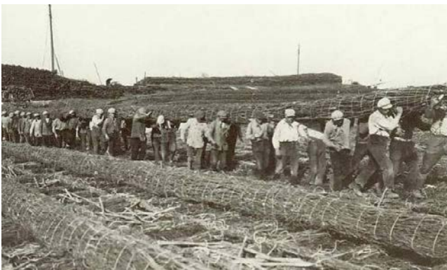
Abb. 44: Herstellung von Absenkungsmatten für den „Afsluitdijk in der Zuiderzee“ am 5. Juni 1930
