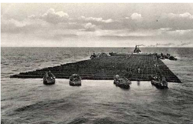
Abb. 46: Transport zinkstuk voor de beteugeling van dijksvak „De Vlieter“ (igzg)
