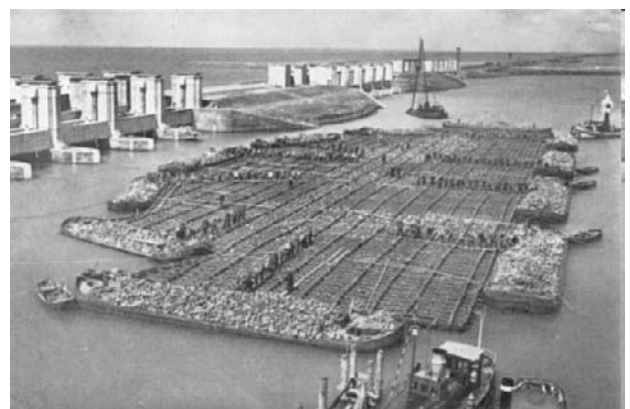
Abb. 47: Beschweren von Absenkungsmatten am Oosterschelddam um 1970
