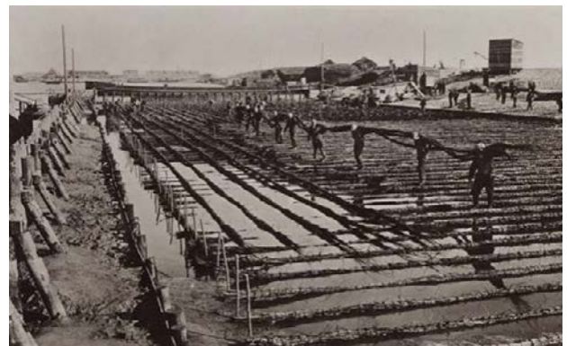
Abb. 45: Zuiderzeewerken Wieringen: Herstellung von 30 x 107 m großen Absenkungsmatten für den „Afsluitdijk“ nach Friesland (igzg)
