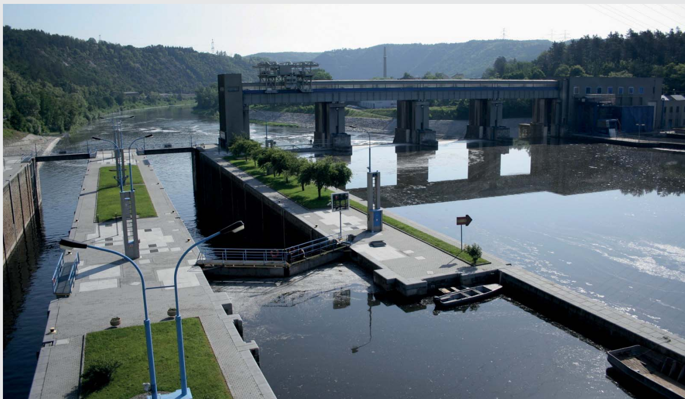
Malá plavební komora (zdroj: Povodí Vltavy, státní podnik)
