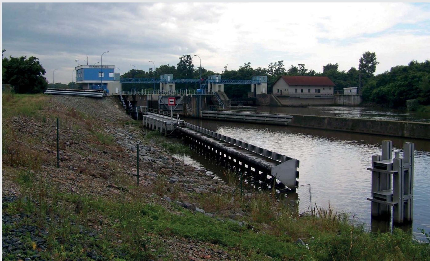
Dolní rejda, jez, MVE (zdroj: Povodí Labe, státní podnik)
