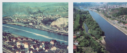
Svádov po výstavbě soustředovacích hrází na konci 19. století a dnes
