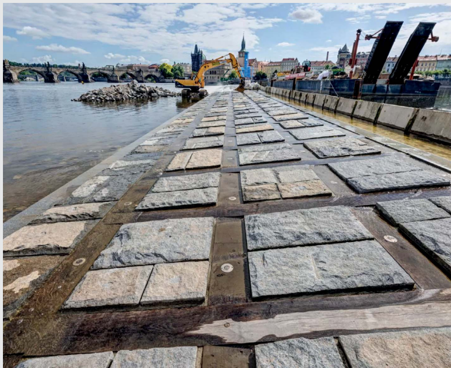
Probíhající rekonstrukce Staroměstského jezu
