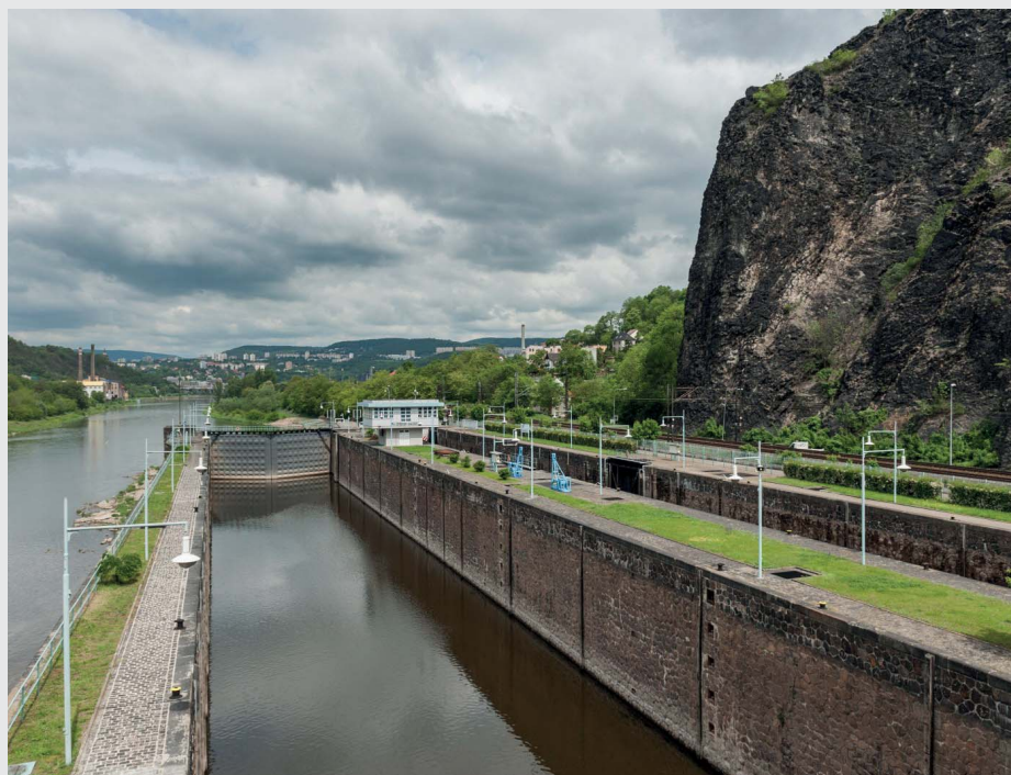
Velká plavební komora (zdroj: Povodí Labe, státní podnik)
