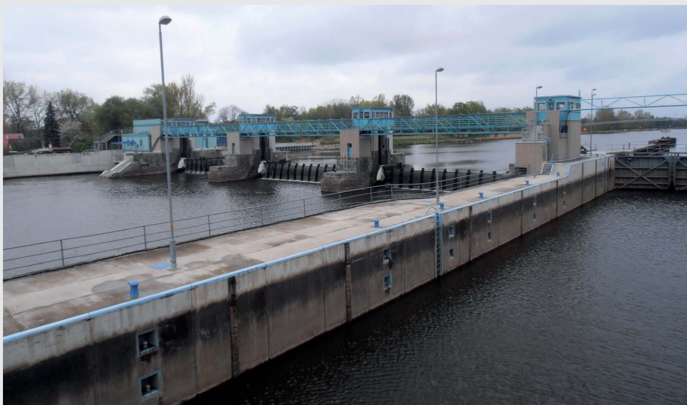
Pohled na jez a část plavební komory z dolní vody [z velínu] (zdroj: Povodí Labe, státní podnik)
