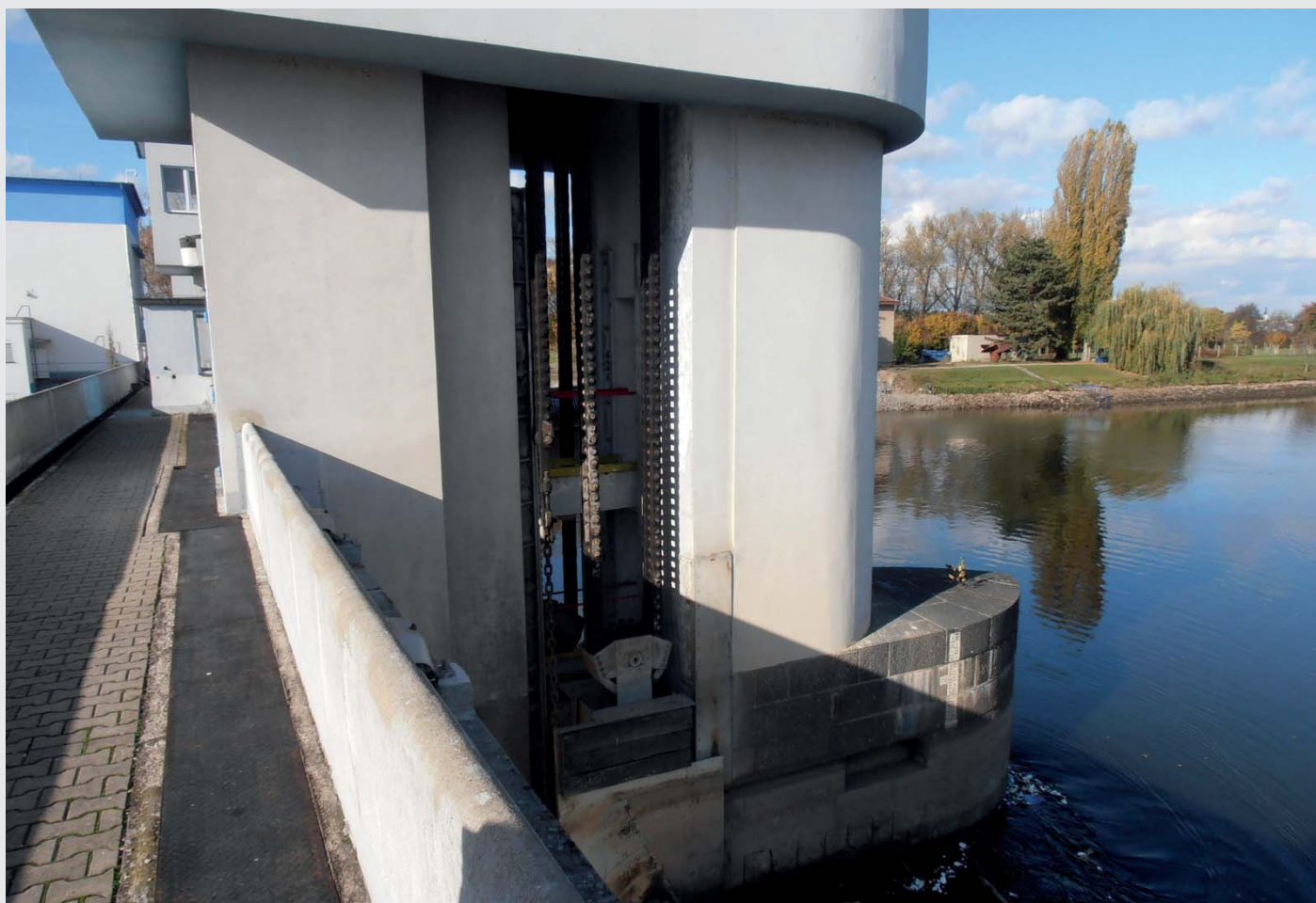
Pohled na Gallovu řetězy z jezové lávky (zdroj: Povodí Labe, státní podnik)
