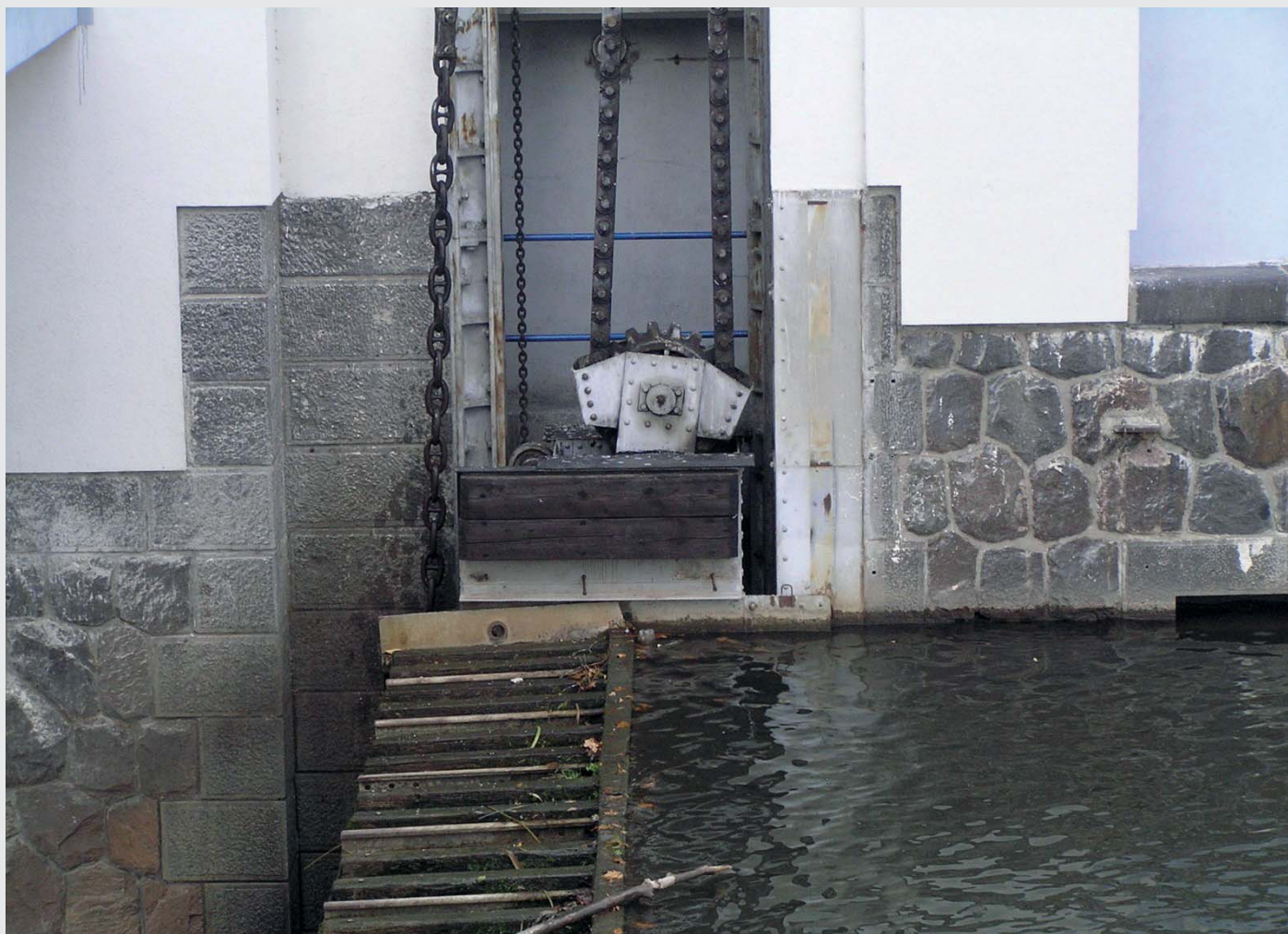
Pohled na Gallův řetěz ve výklenku jezového pilíře (zdroj: Povodí Labe, státní podnik)
