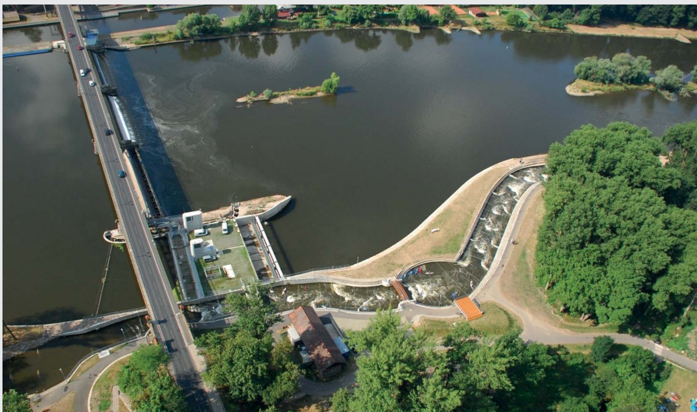
Pohled na vodní elektrárnu a slalomový kanál. Dále 3 jezová pole a v pozadí plavební kanál. [zdroj: RenoEnergie, a.s.]
