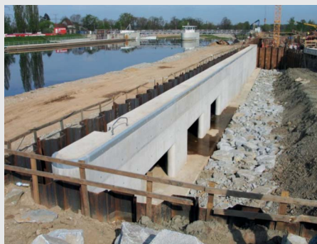
Realizace dělicí zdi u plavební komory České Vrbné
