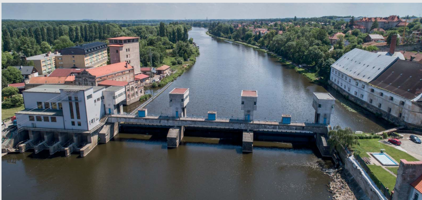
Pohled na jez a MVE (zdroj: Povodí Labe, státní podnik)
