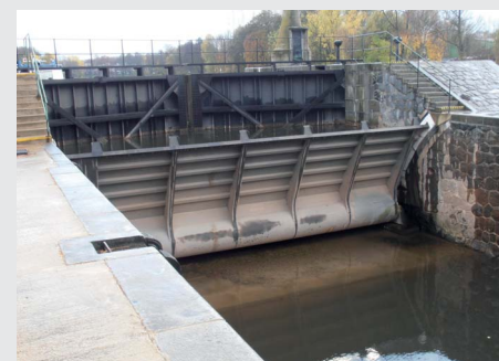
Horní vzpěrná vrata + klapka, pohled proti vodě [zdroj: Povodí Labe, státní podnik]
