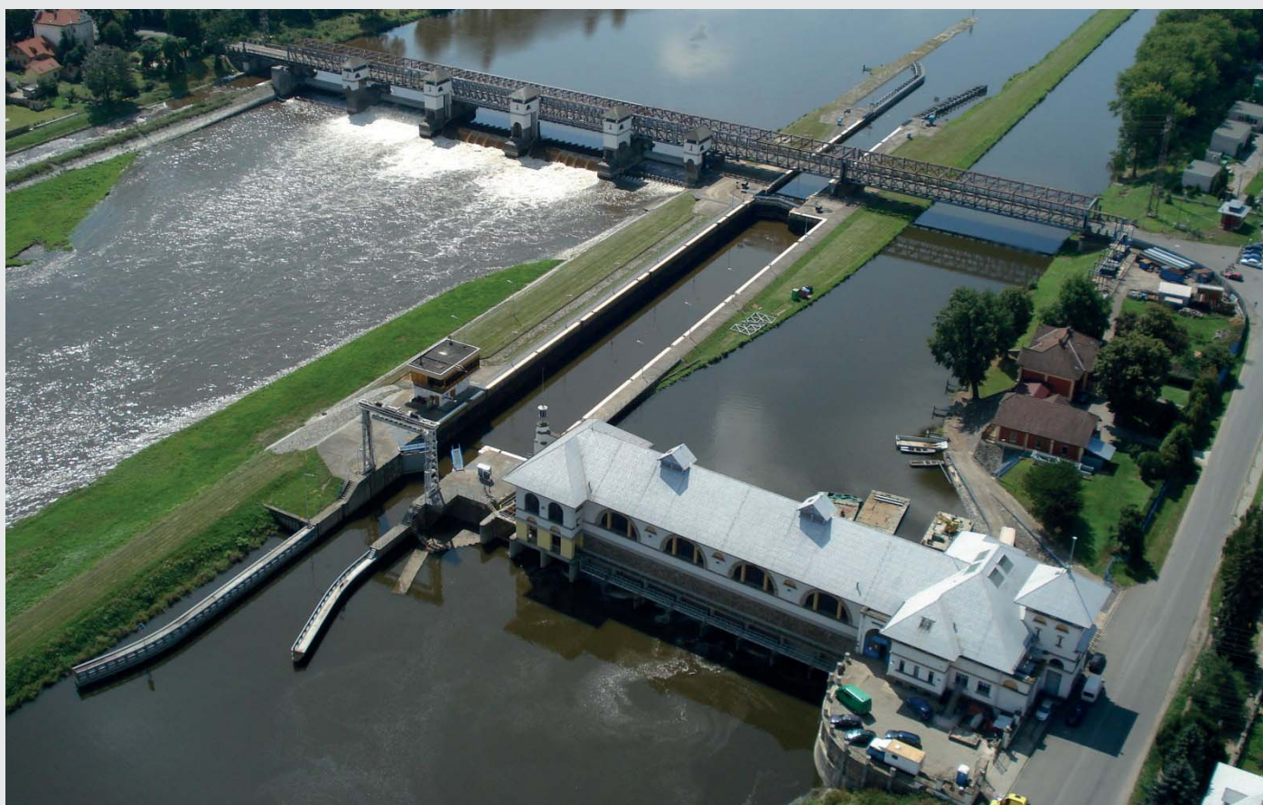
Celkový pohled na vodní dílo [zdroj: Ing. Markéta Komárková]
