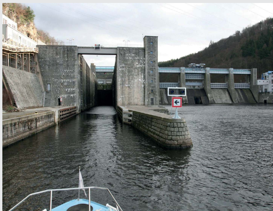
Dolní ohlavi plavební komory (zdroj: Ing. Martin Horský, Ph.D.)
