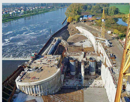
Celkový pohled na stavební jámu MVE (zdroj: Zakládání staveb, a. s.)
