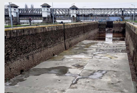
Vypuštěná plavební komora Miřejovice (zdroj: Povodí Vltavy, státní podnik)
