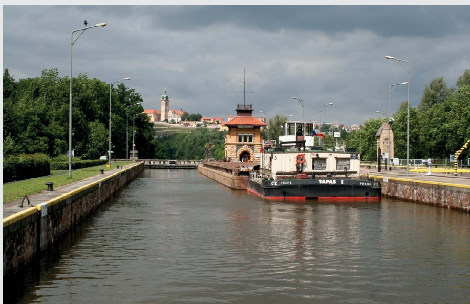
Velká plavební komora v Hoříně (zdroj: Povodí Vltavy, státní podnik)
