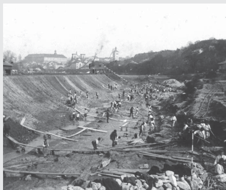
Výstavba plavebních komar (zdroj: Povodí Labe, státní podnik)
