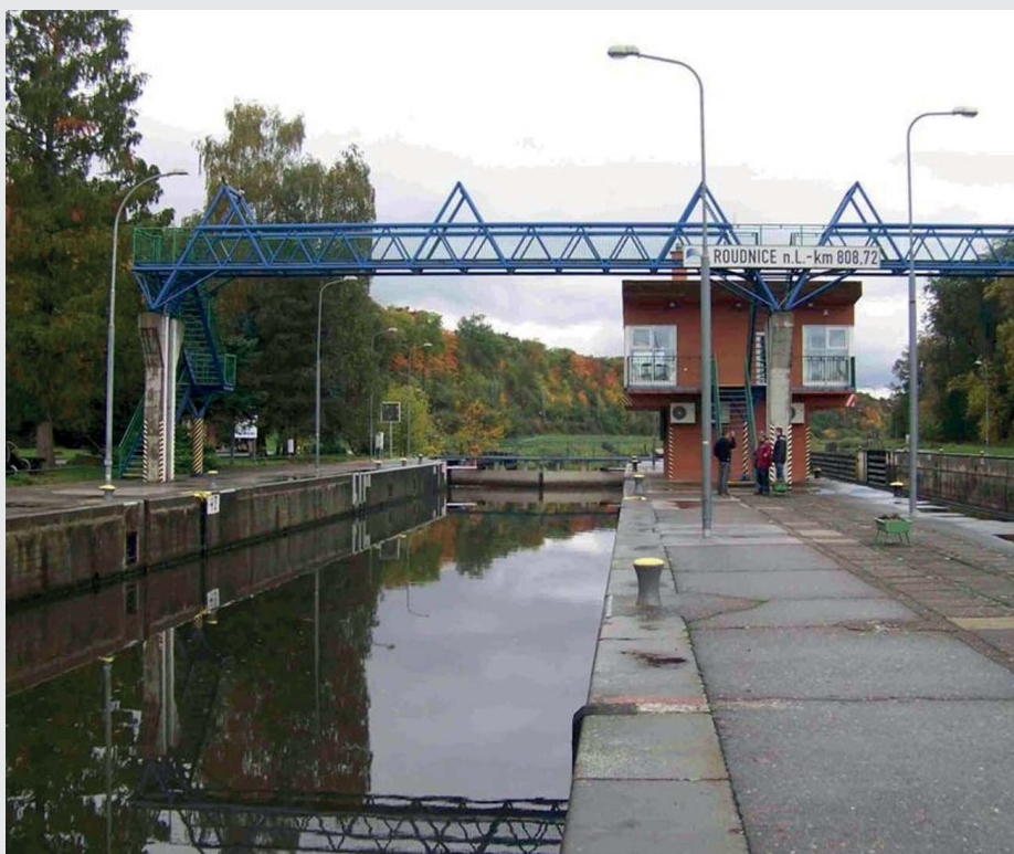
Pohled na velín a plavební komory (zdroj: Povodí Labe, státní podnik)
