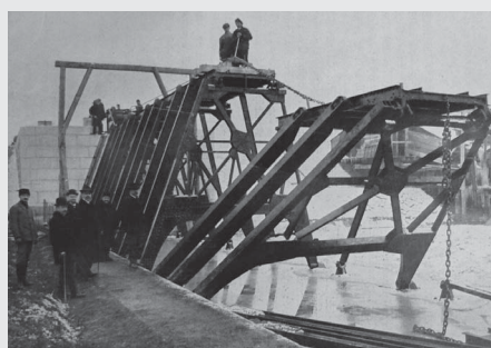
Sklápení hradlového jezu u Litoměřic
