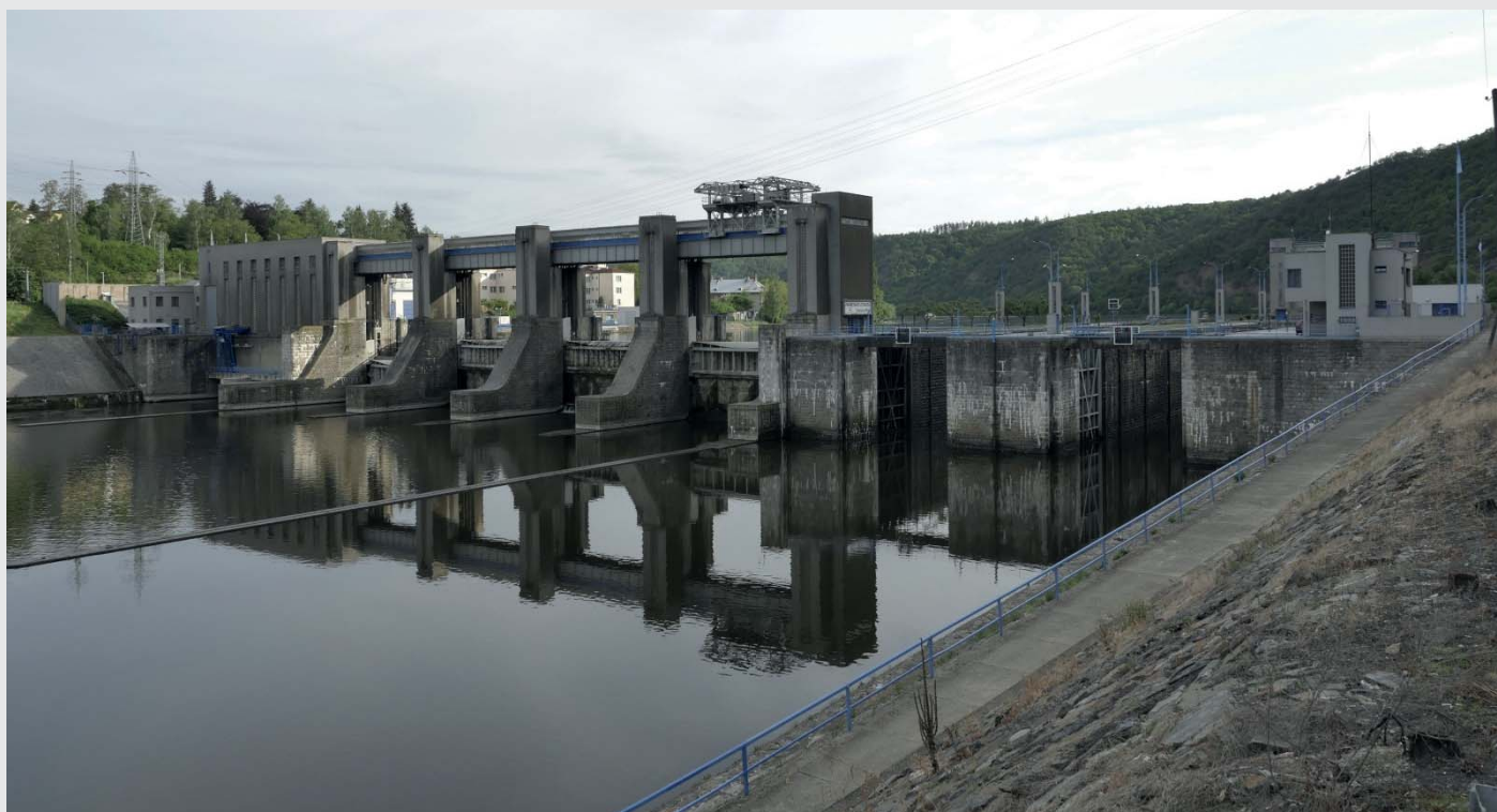
Pohled na jez z levého břehu proti vodě (zdroj: Povodí Vltavy, státní podnik)
