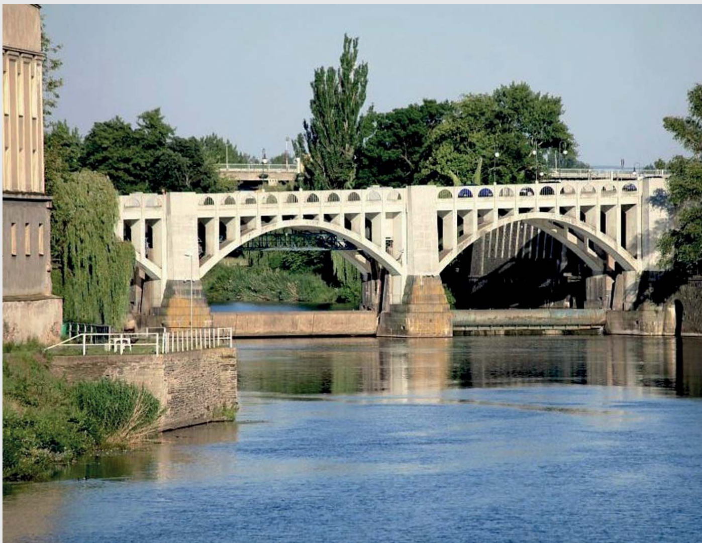
Kolín - Masarykův most, jez - pohled od severozápadu (zdroj: https://www.cestyapamatky.cz )
