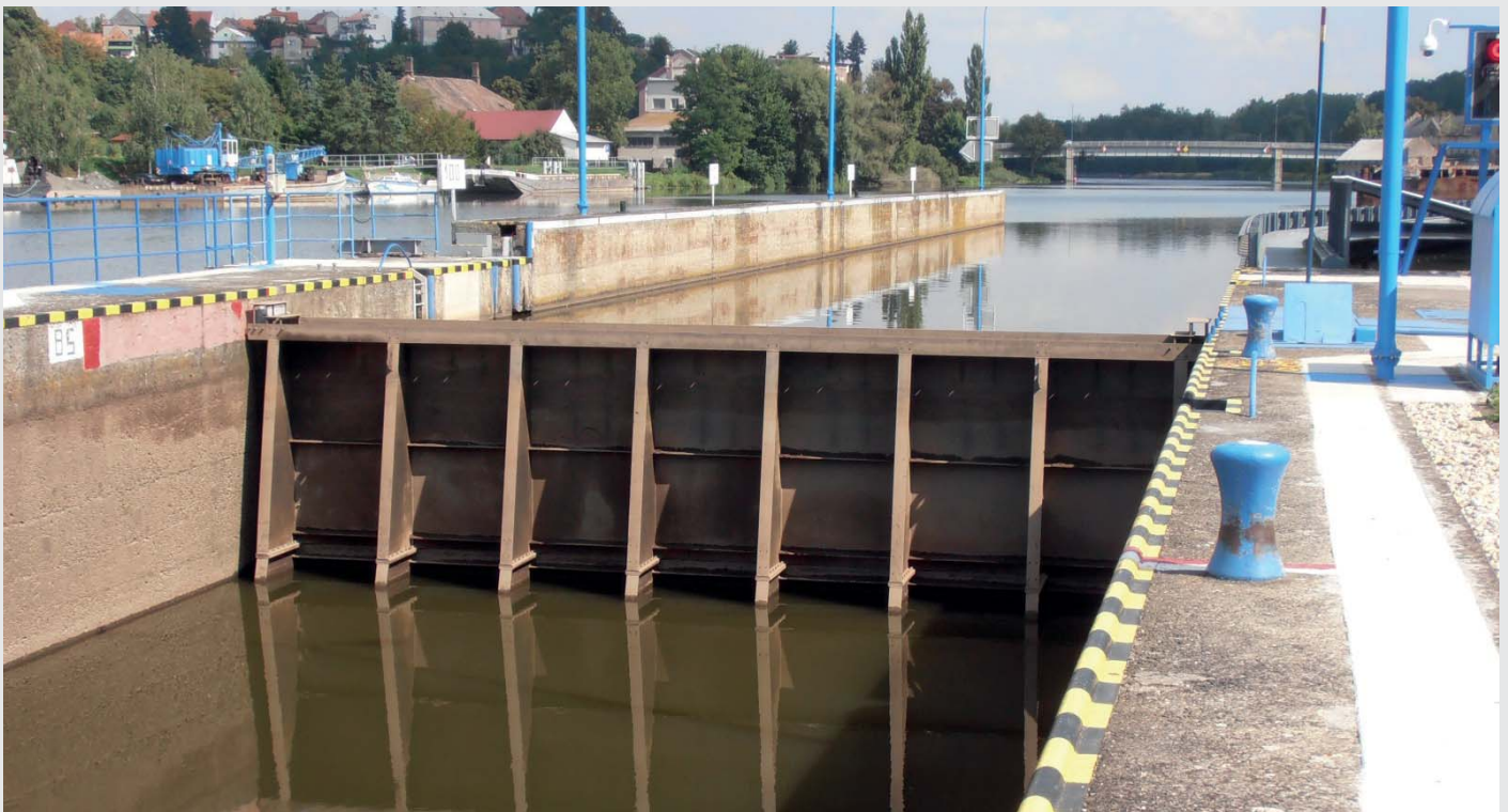
Pohled na Čábelkova sklopná vrata, horní uzávěr PK (zdroj: Povodí Labe, státní podnik)
