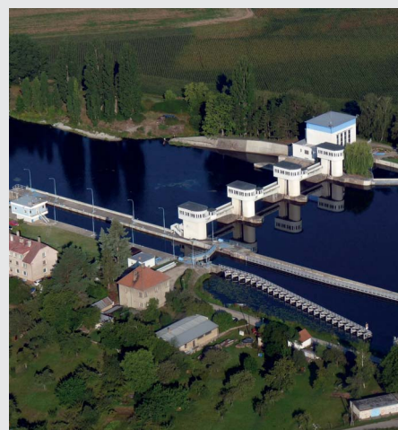
Letecký pohled na zdymadlo Lysá nad Labem
