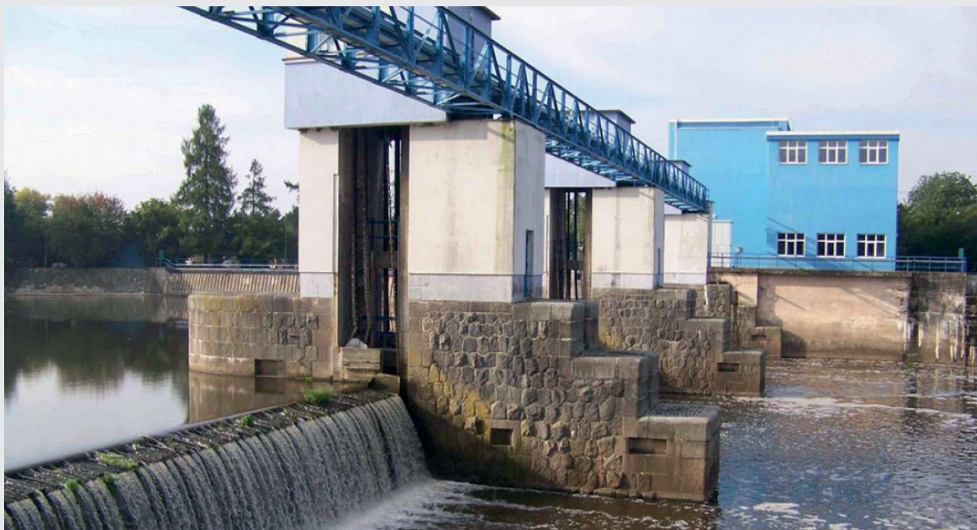
Pohled na jez, jezovou lávku a MVE – detail (zdroj: Povodí Labe, státní podnik)
