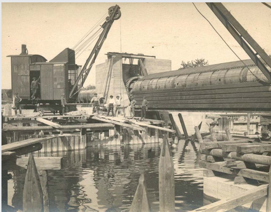
Kolín – stavba válcového jezu (1920)
