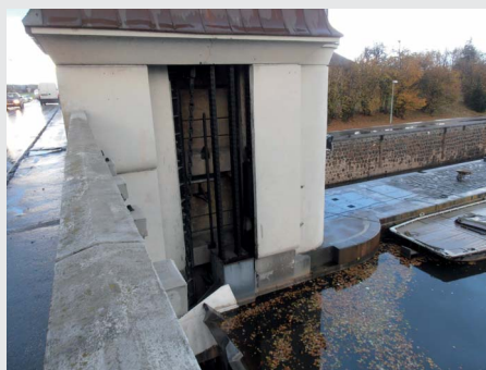
Jezový pilíř, ovládací Gallovy řetězy (zdroj: Povodí Labe, státní podnik)
