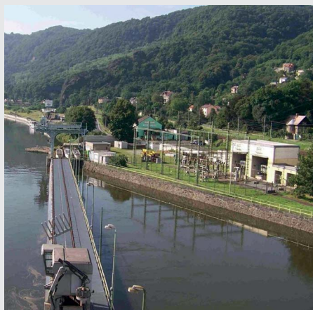
Náhled na vodní elektrárnu – hrubé česle (zdroj: Povodí Labe, státní podnik)
