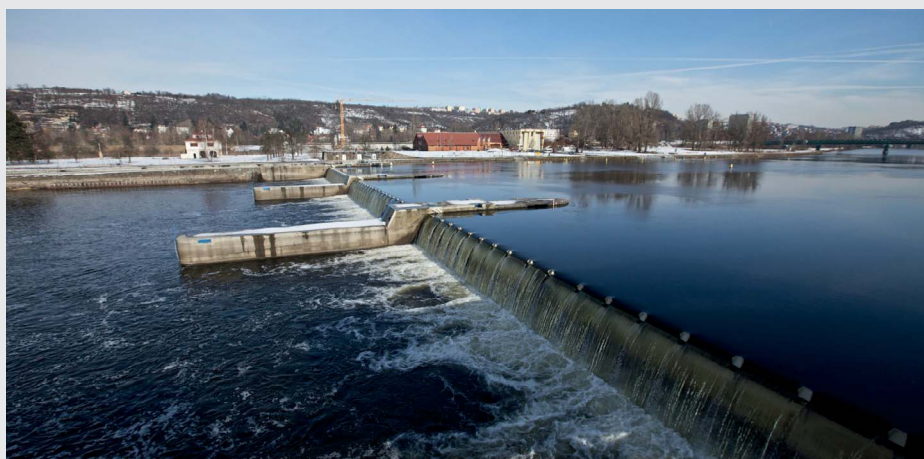
Pohled na jez a vodácký kanál (na protějším břehu) (zdroj: Povodí Vltavy, státní podnik)
