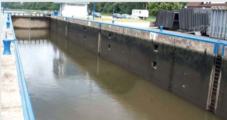
Pohled na vyprázdňenou PK a výstroj PK - pohled od horního ohlavi (zdroj: Povodí Labe, státní podnik)
