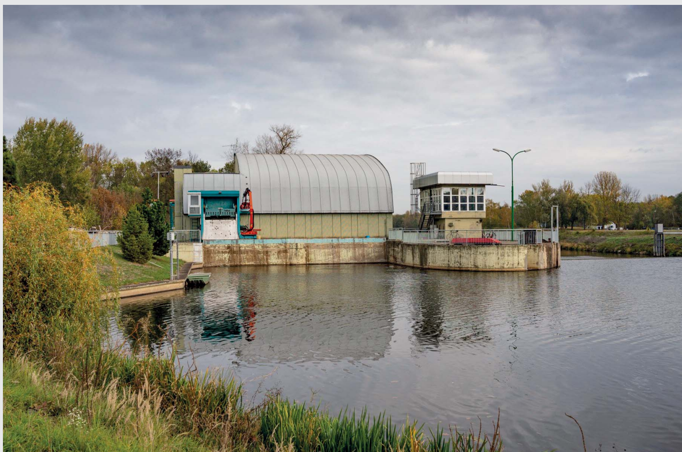
Malá vodní elektrárna – nátok (zdroj: The photonaut – Wikipedia, 2018)
