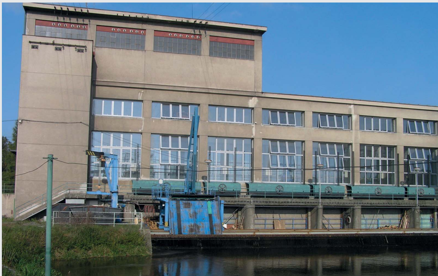
Čistící stroj jemných česlí MVE (zdroj: Povodí Labe, státní podnik)
