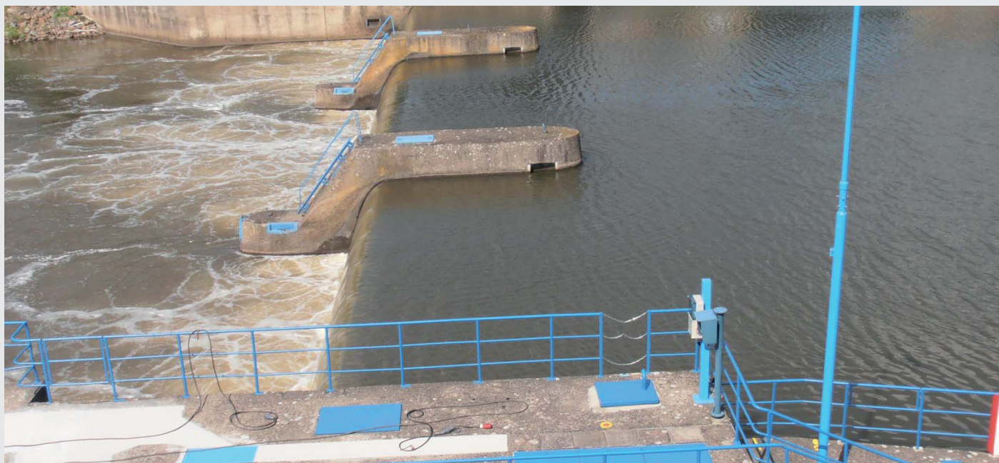
Pohled z velínu na pilíře a klapky jezu (zdroj: Povodí Labe, státní podnik)
