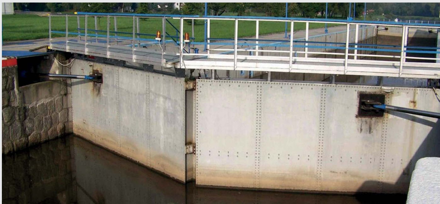
Vzpěrná vrata v horním ohlavi (zdroj: Povodí Labe, státní podnik)
