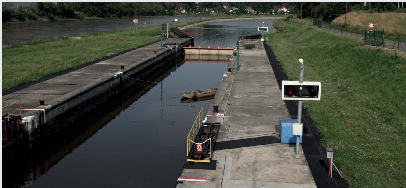
Klapková vrata v horním ohlavi plavební komory [zdroj: Povodí Vltavy, státní podnik]
