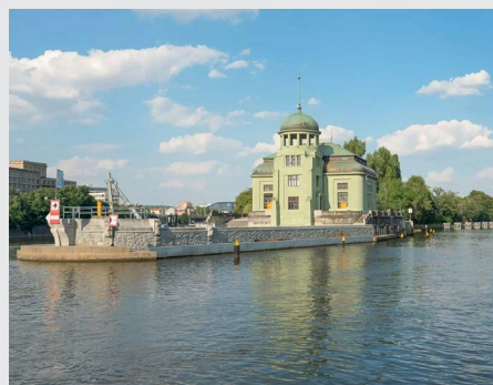
MVE Štvanice na Vltavě v Praze
