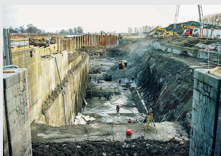
Stavební jímka pro malou vodní elektrárnu (zdroj: Zakládání staveb, a. s.)
