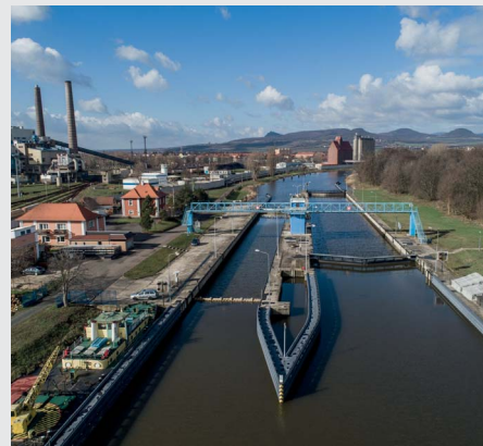
Plavební komory – pohled po proudu (zdroj: Povodí Labe, státní podnik)
