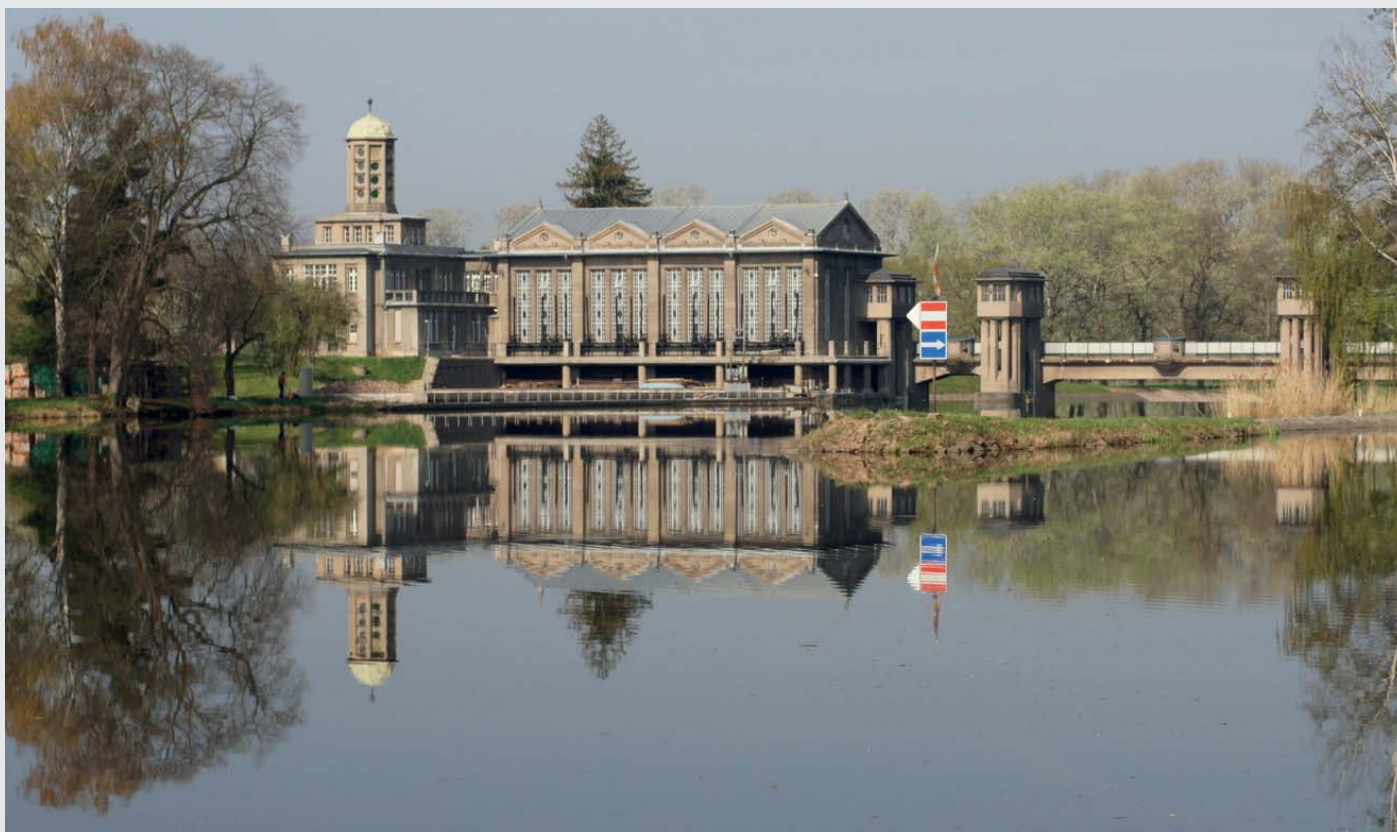
Budova MVE (zdroj: Aloxe)
