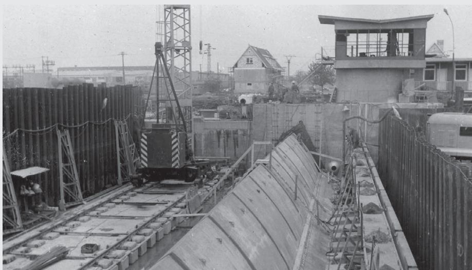
Rekonstrukce jezu (1972–1973) – první pole (zdroj: Povodí Labe, státní podnik)
