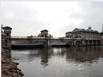
Pohled z podjezí na jez a MVE (zdroj: Fakulta stavební ČVUT v Praze)
