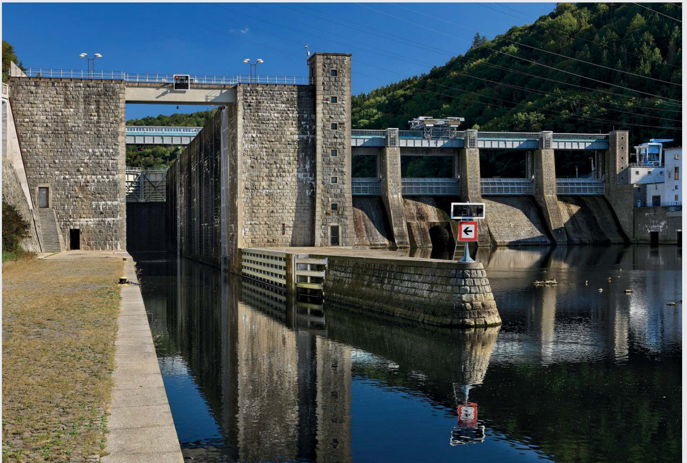
Dolní ohlavi plavební komory (zdroj: Povodí Vltavy, státní podnik)
