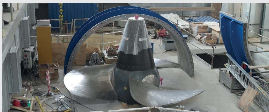
Montáž Kaplanovy turbíny malé vodní elektrárny [zdroj: energieia o.p.s.]
