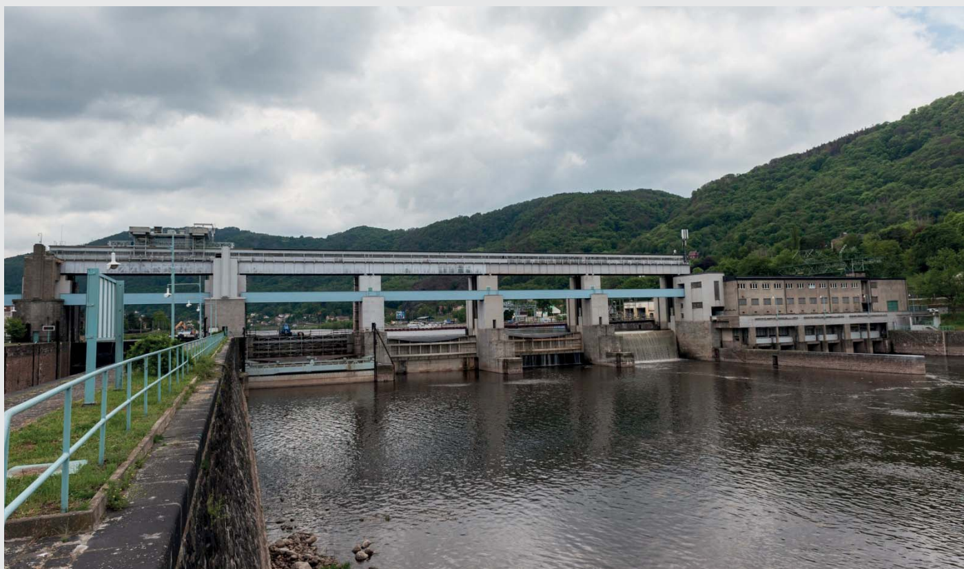
Čtyři jezová pole a vpravo budova vodní elektrárny (zdroj: Povodí Labe, státní podnik)
