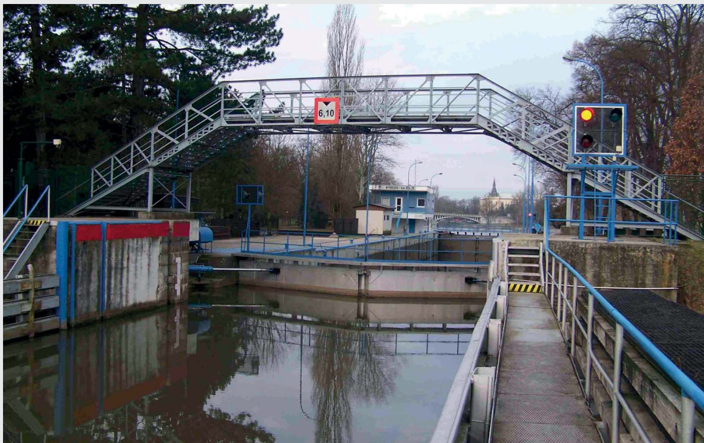
Horní ohlaví plavební komory (zdroj: Povodí Labe, státní podnik)
