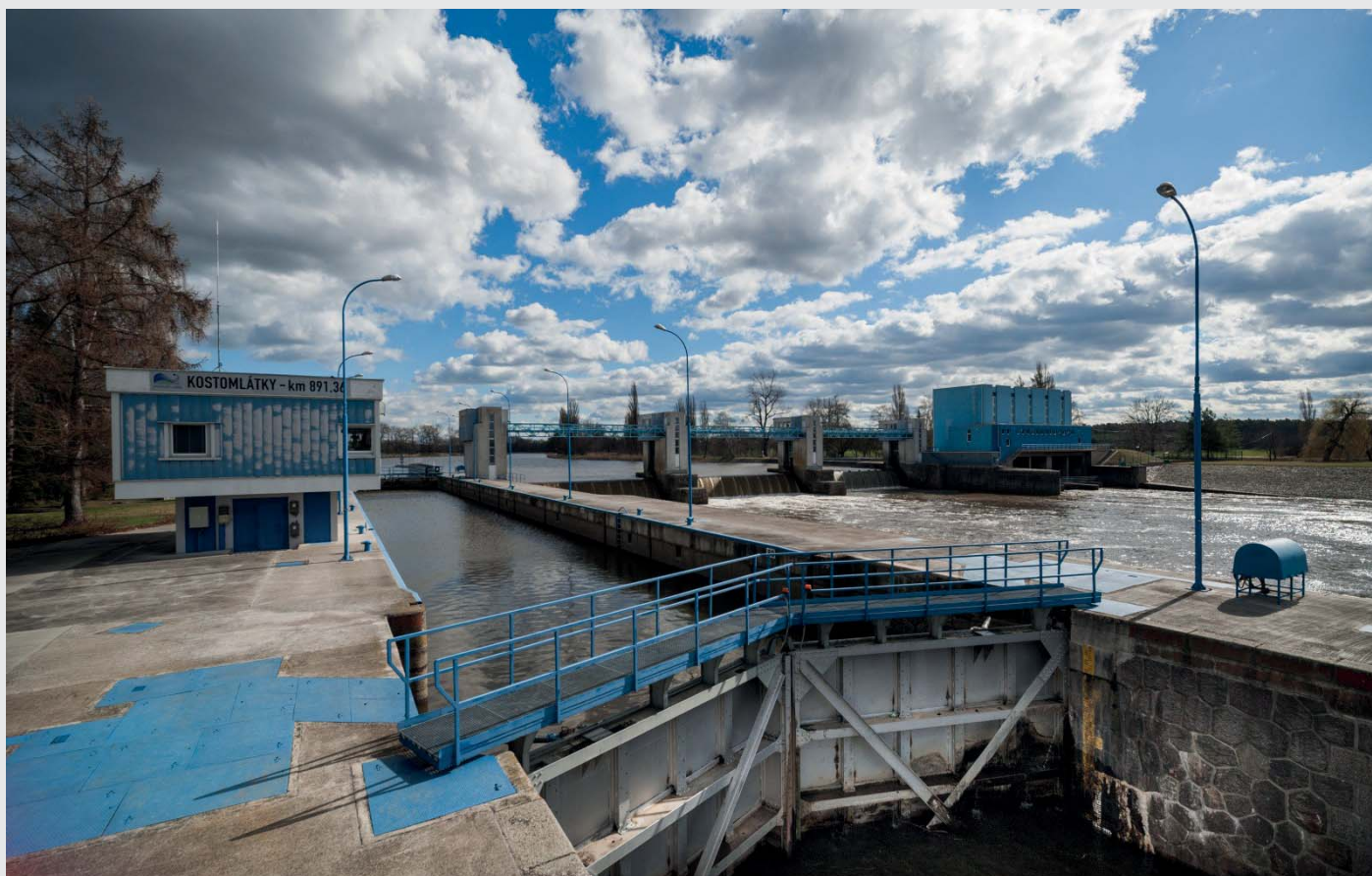
Dolní vzpěrná vrata PK (zdroj: Povodí Labe, státní podnik)
