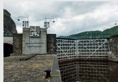
Dolní ohlaví plavebních komor (zdroj: Povodí Labe, státní podnik)
