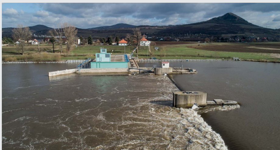
Pohled na jezové pole a budovu MVE (zdroj: Povodí Labe, státní podnik)
