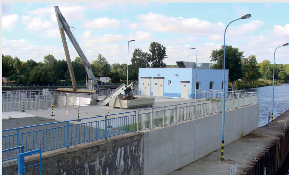
Pohled na novou MVE – v popředí čistící stroj česlí (zdroj: Povodí Labe, státní podnik)
