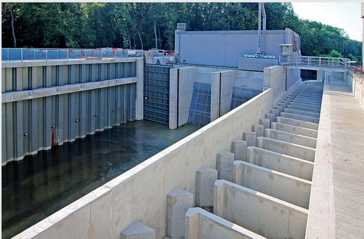
Vtok MVE s rybím přechodem (zdroj: Zakládání staveb a.s.)
