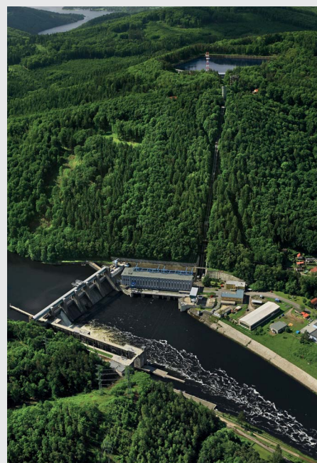
Letecký pohled na vodní dílo Štěchovice s budovami VE, přivaděčem a horní nádrží Homole přečerpávací VE [zdroj: Povodí Vltavy, s.p.]
