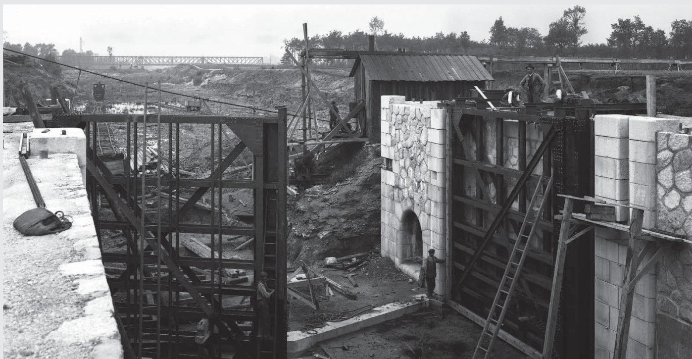
Výstavba plavební komory. Pohled na dolní vrata Z. B. 1922 (zdroj: Povodí Labe, státní podnik)
