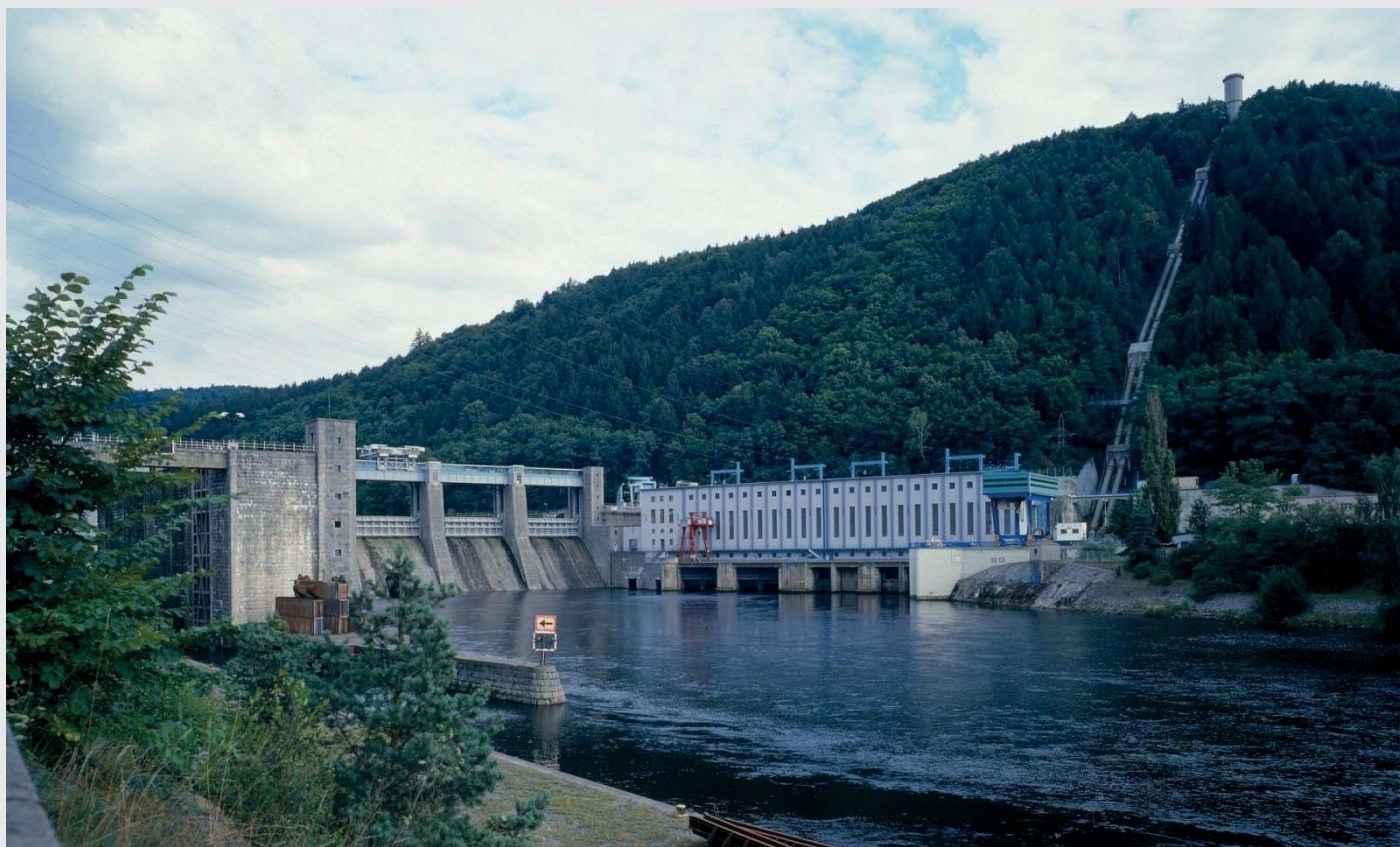
Budova VE Štěchovice I a přiváděcí potrubí z horní nádrže (zdroj: ČEZ a.s.)
