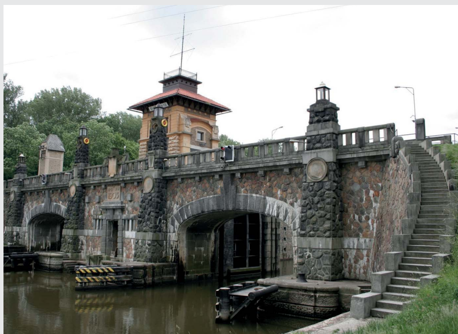
Pohled na dolní ohlavi plavebních komor v Hoříně (zdroj: Povodí Vltavy, státní podnik)
