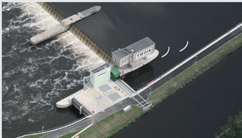
Levé pole jezu, velín a vodní elektrárna Troja (zdroj: Povodí Vltavy, státní podnik)
