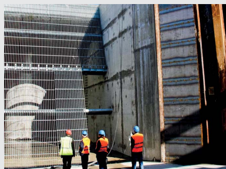
Vtok do vodní elektrárny s česlemi (foto z výstavby) (zdroj: HYDROPRO Engineering s.r.o.)
