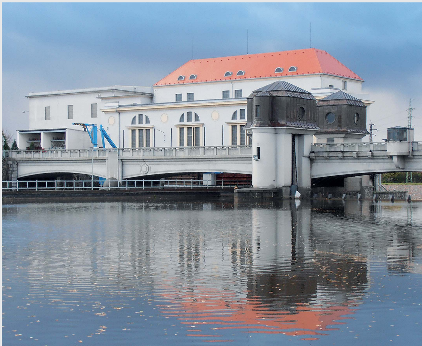
MVE, pohled po vodě (zdroj: Povodí Labe, státní podnik)
