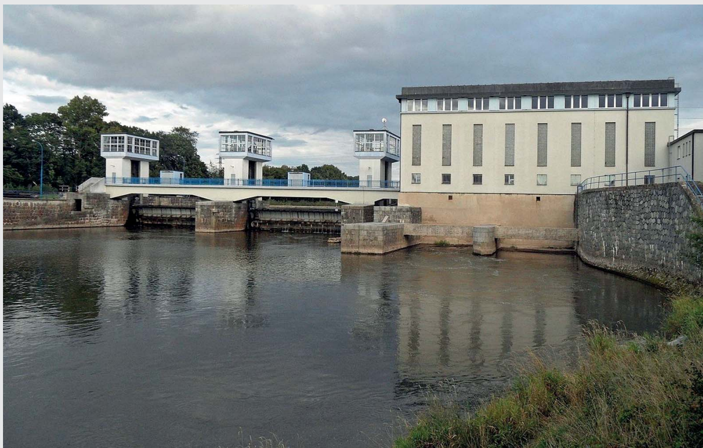
Pohled proti vodě na budovu MVE (zdroj: Stribrohorak)
