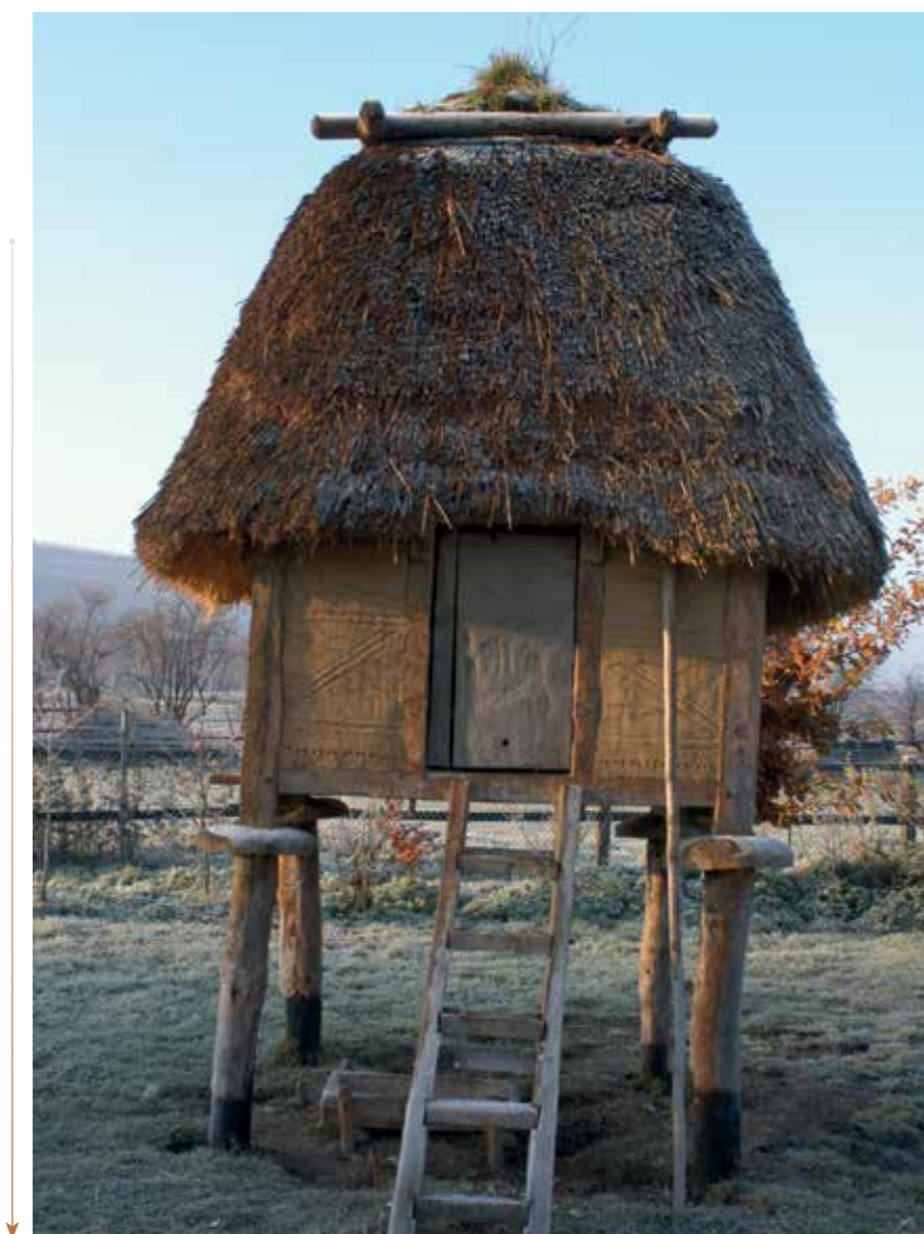
02 // Ein rekonstruierter eisenzeitlicher Vierpfostenspeicher in Titz-Höllen im Rheinland. Zwischen den etwa 1 m aus dem Erdboden ragenden Pfosten und der Bodenplatte lagen große Baumscheiben oder eventuell auch Steinplatten, die verhindern sollten, dass Mäuse eindringen und die eingelagerten Nahrungsmittel fressen und verschmutzen (Foto: LVR-Amt für Bodendenkmalpflege im Rheinland/U. Geilenbrügge).
