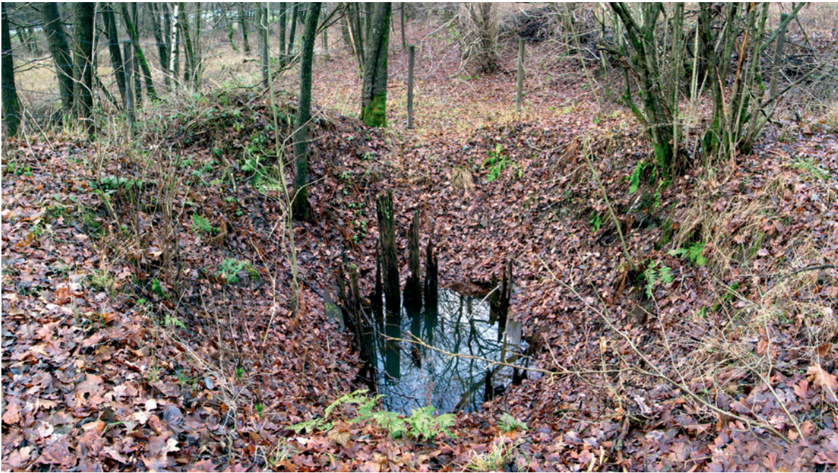
51 // Abgesoffener Schacht mit Resten des Holzbaus im Montanareal Rhonard bei Olpe (Foto: LWL-Archäologie für Westfalen/H. Menne).
