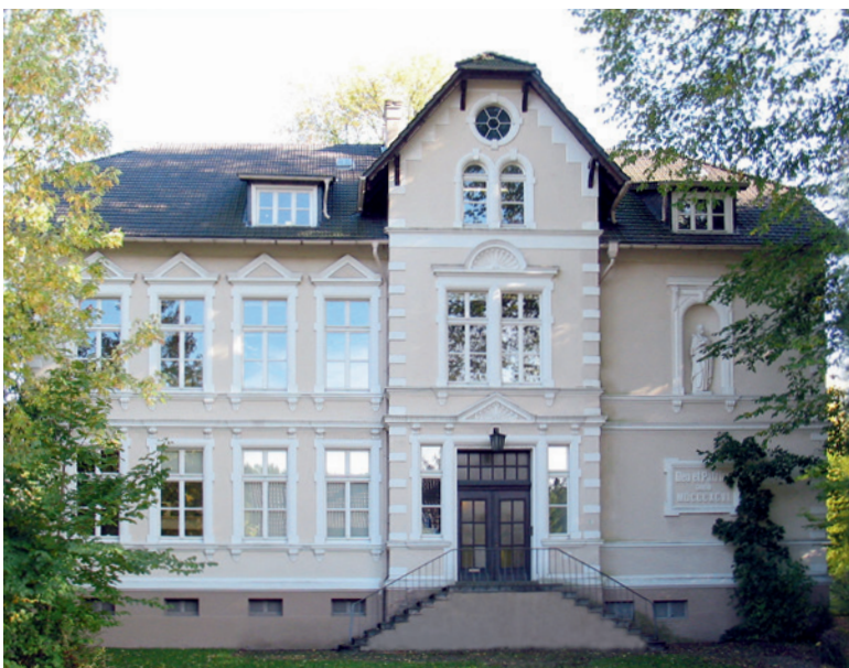
02 // Blick auf die Straßenseite der Außenstelle Olpe, die ehemals der repräsentative Eingangsbereich einer Schule war. Der heutige Zugang samt Parkplätzen befindet sich rückseitig (Foto: LWL-Archäologie für Westfalen/H. Menne).
