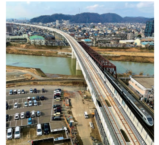
Hokuriku Shinkansen Asuwagawa Bridge (Fukui-shi, Fukui)
