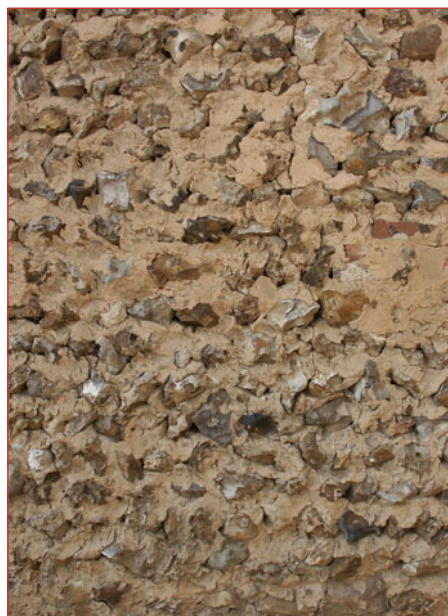
Maçonnerie de silex
