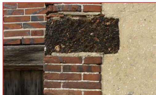
Maçonnerie de brique et grison et moellons enduits.
