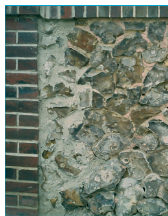
Mur en silex et chaîne en brique.
