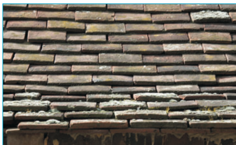
Toit débordant en tuile
