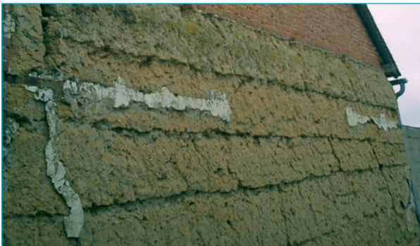
Mur en bauge. Broué.
