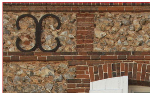
Maçonnerie de brique et silex.
