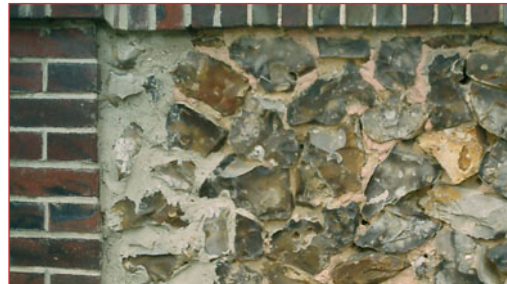
Maçonnerie de brique et silex.
