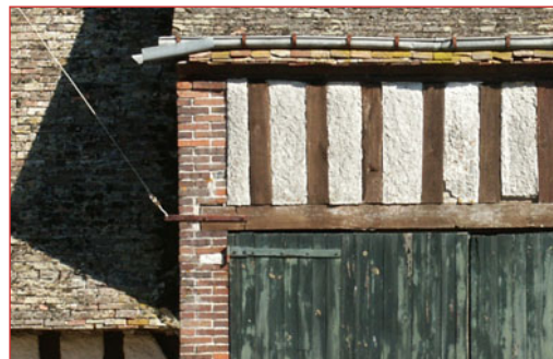
Colombages protégés par un lait de chaux.
