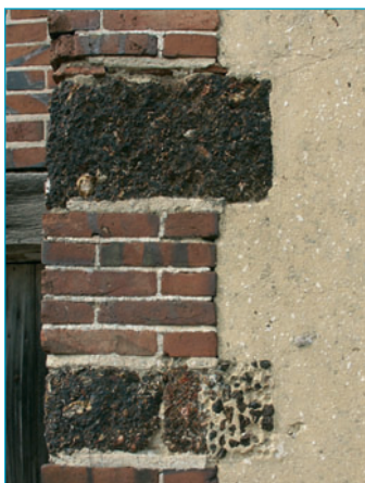
Maçonnerie en pierre de grison et brique.
