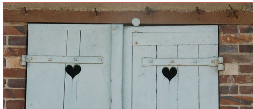
Jour de ventilation en forme de cœur
