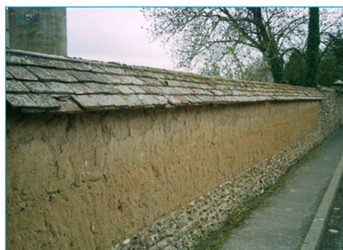
Mur en terre crue, soubassement silex. Broué.
