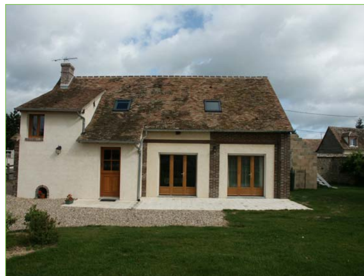
En dessous : la grange réaménagée en gîte au printemps 2007.
