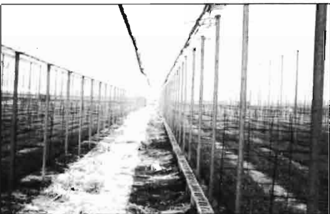
La ventilación cenital (en la cubierta) del invernadero es necesaria para reducir los excesos de temperatura y mejorar las condiciones higrométricas y de composición del aire del invernadero.
