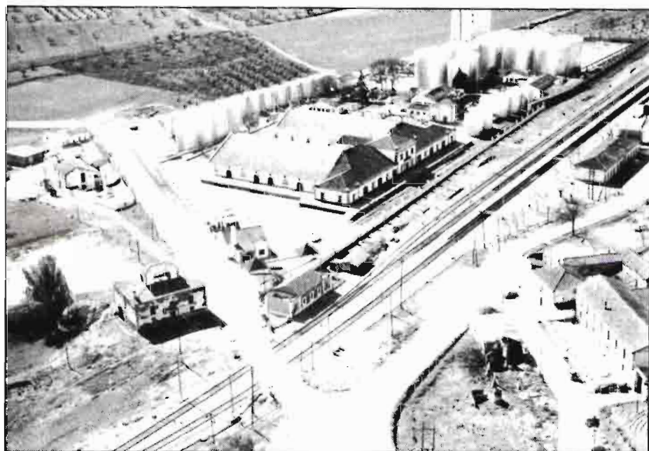
Almacén regulador de aceites y Almazara Experimental. Montoro (Córdoba).
