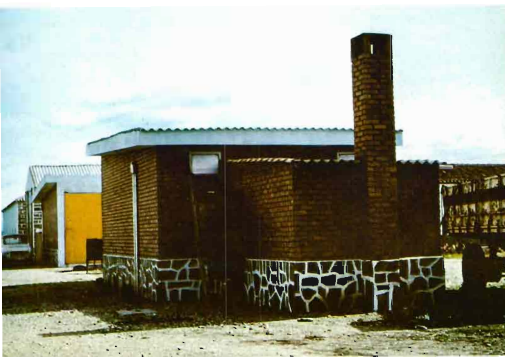
Fig. 12.—Secadero construido en «obra de fábrica».
