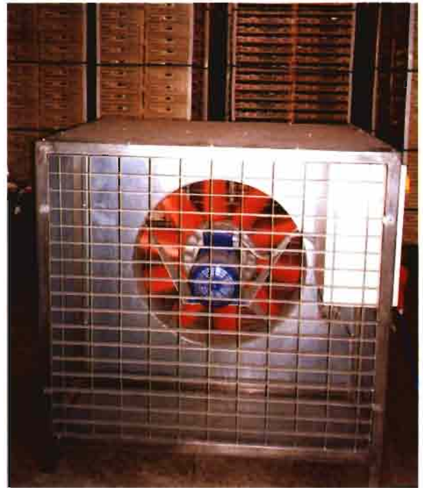
Transformación de cámara normal en prerrefrigeración con ayuda de un ventilador de refuerzo.
